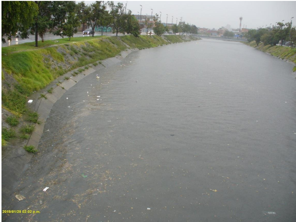
Figura 33. Canal río Salitre con nivel de agua casi completo de la sección revestida en el tramo de estudio.
