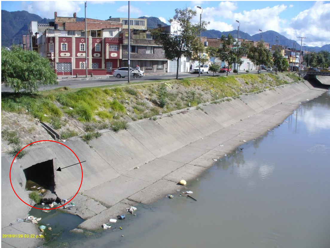
Figura 5. Aliviadero del canal Salitre en la calle transversal 56a con calle 72
