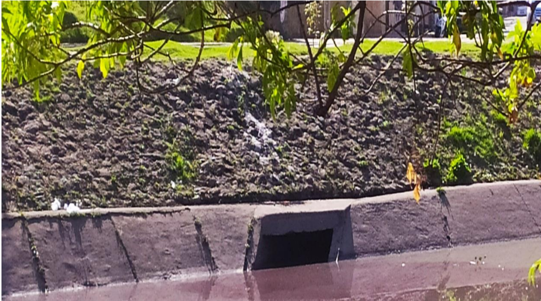
Figura 9. Recubrimiento en Roca del canal río Salitre.
