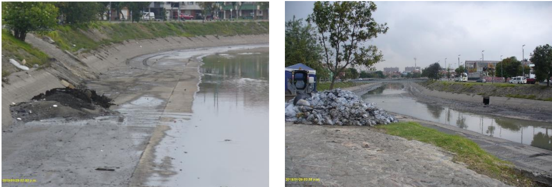
Figura 7. Trabajos de limpieza en el Canal río Salitre
