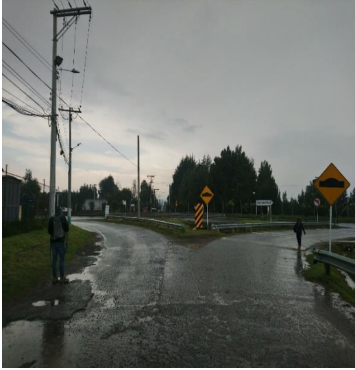
Figura 24. Fotografía del eje y la sección en el K0+700 Vía MO-5 (El Charquito 1).
