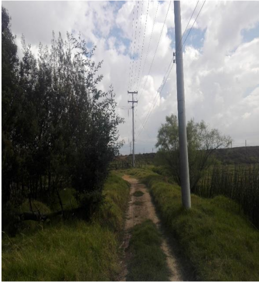
Figura 28. Fotografía del eje y la sección en el K1+800 Vía MO-R1 (Cruz Verde).
