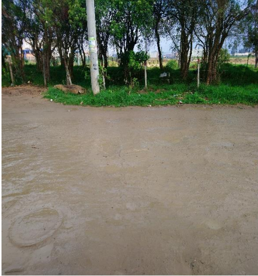
Figura 45. Fotografía del eje y la sección en el Obras de drenaje vía El Charquito 2.
