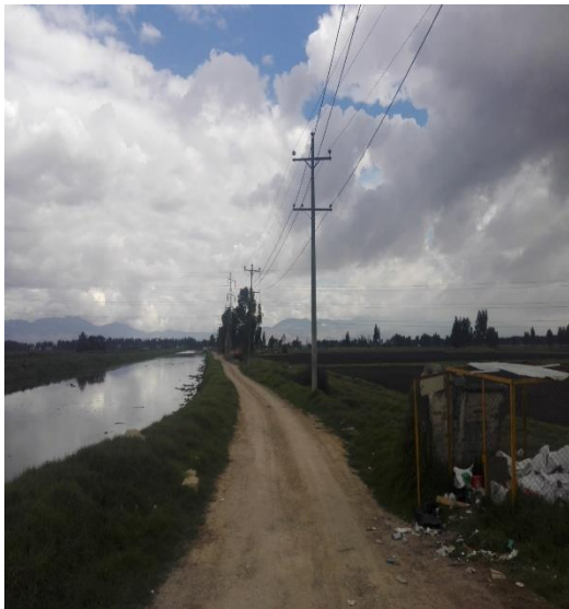
Figura 27. Fotografía del eje y la sección en el K0+000 Vía MO-R1 (Cruz Verde).
