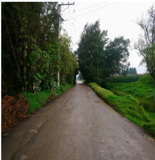
Figura 23. Fotografía del eje y la sección en el K0+000 Vía MO-5 (El Charquito 1).
