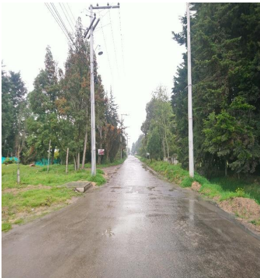
Figura 43. Fotografía del eje y la sección en el K0+000 Vía MO-R5 (El Charquito 2).
