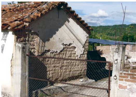
Figura 7. Casas de adobe en Paso Morelos, Guerrero.
