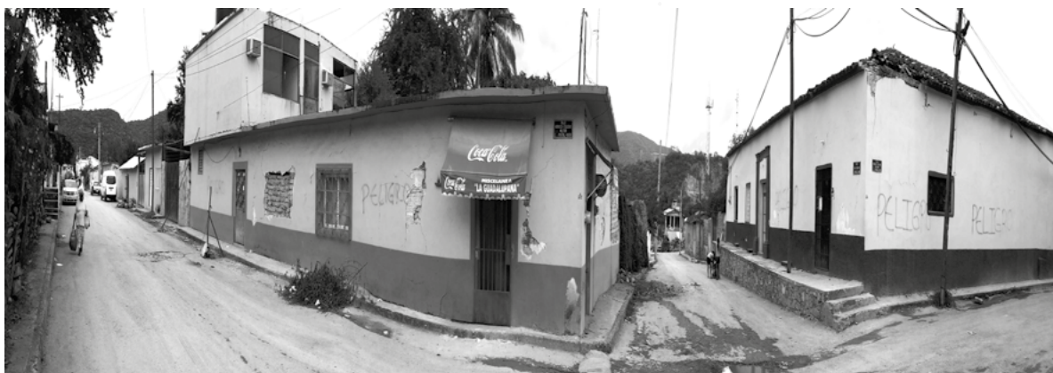
Figura 12. Construcciones tradicionales alteradas en su estructura formal y el sistema constructivo. Municipio de Atenango del Río, Guerrero.
