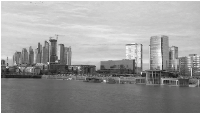
Figura 3. Renovación antiguo Puerto Madero–Sector Este.
