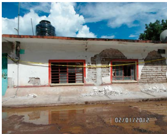
Figura 9. Casa con muros de adobe y elementos de concreto en Atenango del Río.
