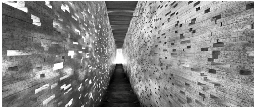
Figura 15. Después de múltiples combinatorias materiales y constructivas, el arquitecto se decide por el granito rosa colocado a hueso, en una insinuación de apilamiento, que libera a intervalos aleatorios pequeños agujeros que filtran el paisaje y la luz, recreando en clave de modernidad, atmósferas recurrentes en las salas de la Alhambra. La sección constructiva evidencia el cuidado respecto con la historia de una intervención reversible que se convierte en una oferta sensorial, como puede verse en la imagen.
