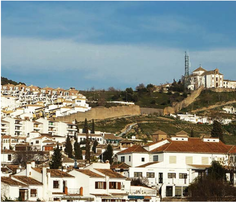
Figura 8. Vista de la muralla nazari desde el campanario de la iglesia de San Bartolomé. A duras penas se distingue la intervención contemporánea en la muralla y las escaleras de acceso. Por el contrario, es ostensible la colonización ilegal de casas cueva en el vacío acotado por la muralla y sobre todo es especialmente ruidosa la urbanización Cármenes de San Miguel Alto al otro lado.
