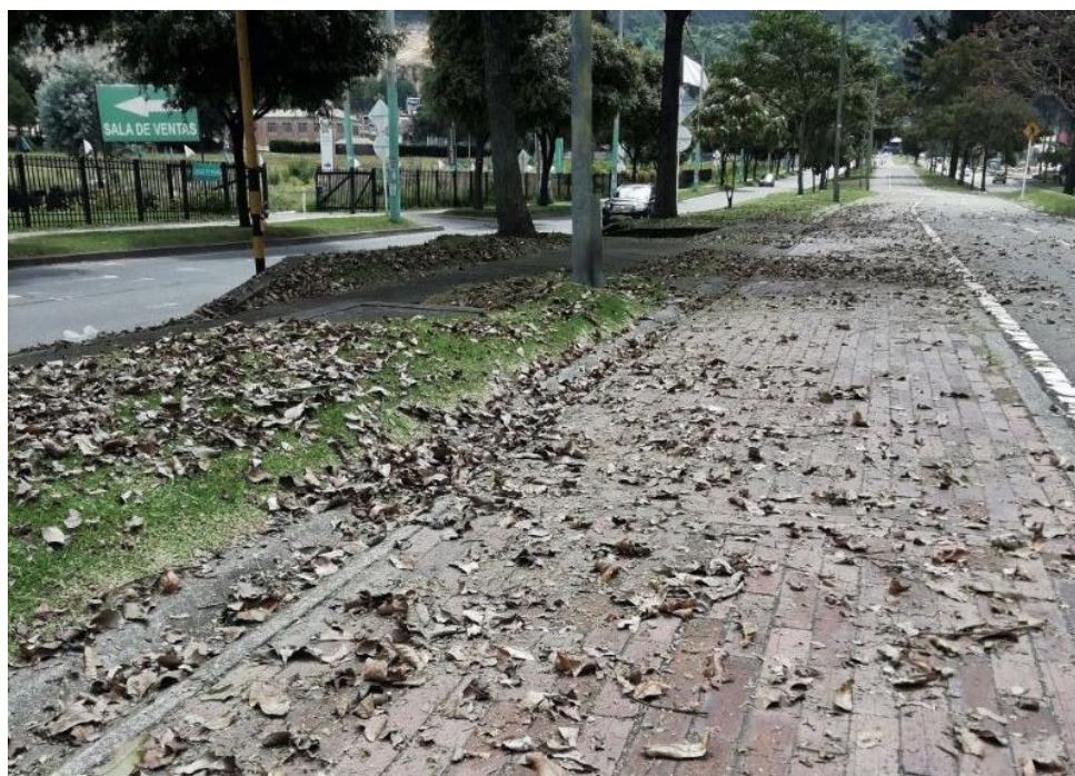
Gráfico 10. Deficiencia en el mantenimiento del espacio público por causa de la caducidad de las hojas de los árboles. Fuente: Toma propia. (2019)
