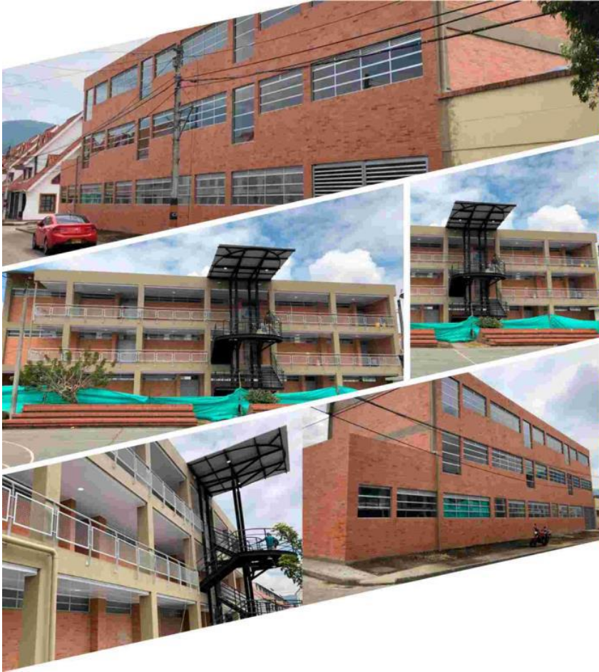
Figura 13: Colegio Facatativa. Fuente: LEEGS Ingenieria SAS
