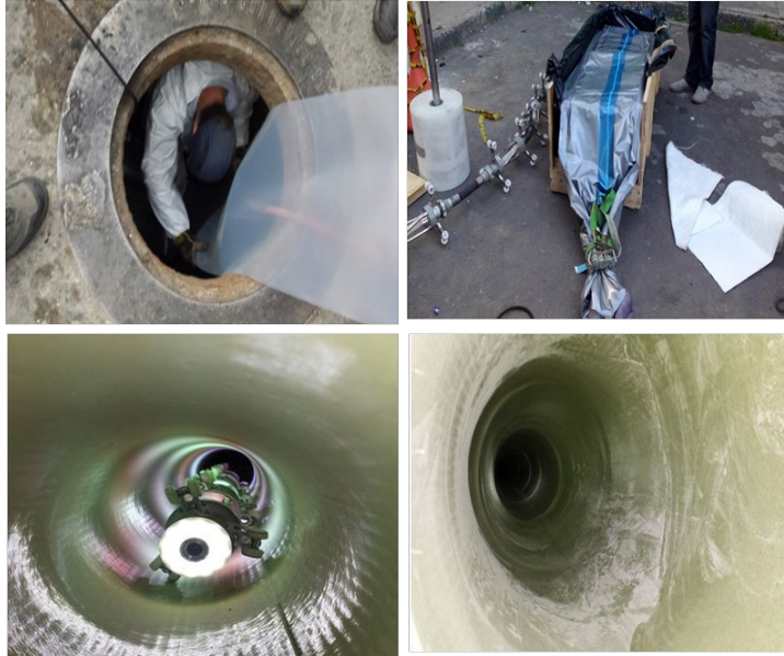
Figura 5. Revestimiento de alcantarillado principal CIPP.
