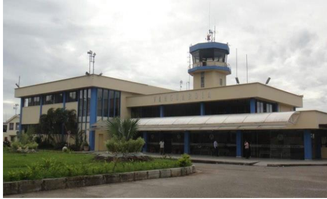
Ilustración 17: Vista terminal actual desde lado Tierra Fuente: Propia
