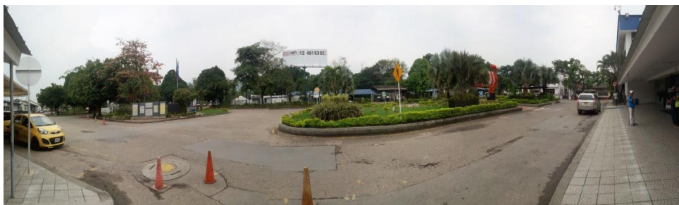
Ilustración 21: Área de recogida y llegada de pasajeros de taxis / pavimento deteriorado. (Fuente: AIP COLOMBIA. (2018) SKVV-Villavicencio)
