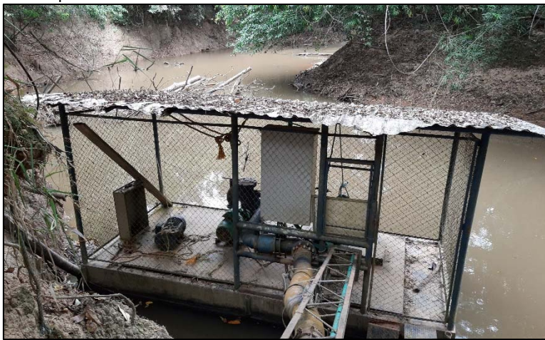
Figura 8. Estructura de Captación
