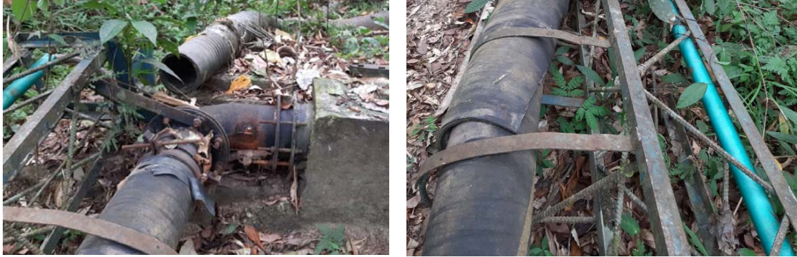
Figura 9. Sistema de anclaje Bocatoma Flotante.
