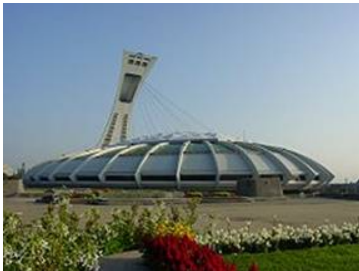
El moderno estadio y su torre inclinada, una década después de los Juegos
