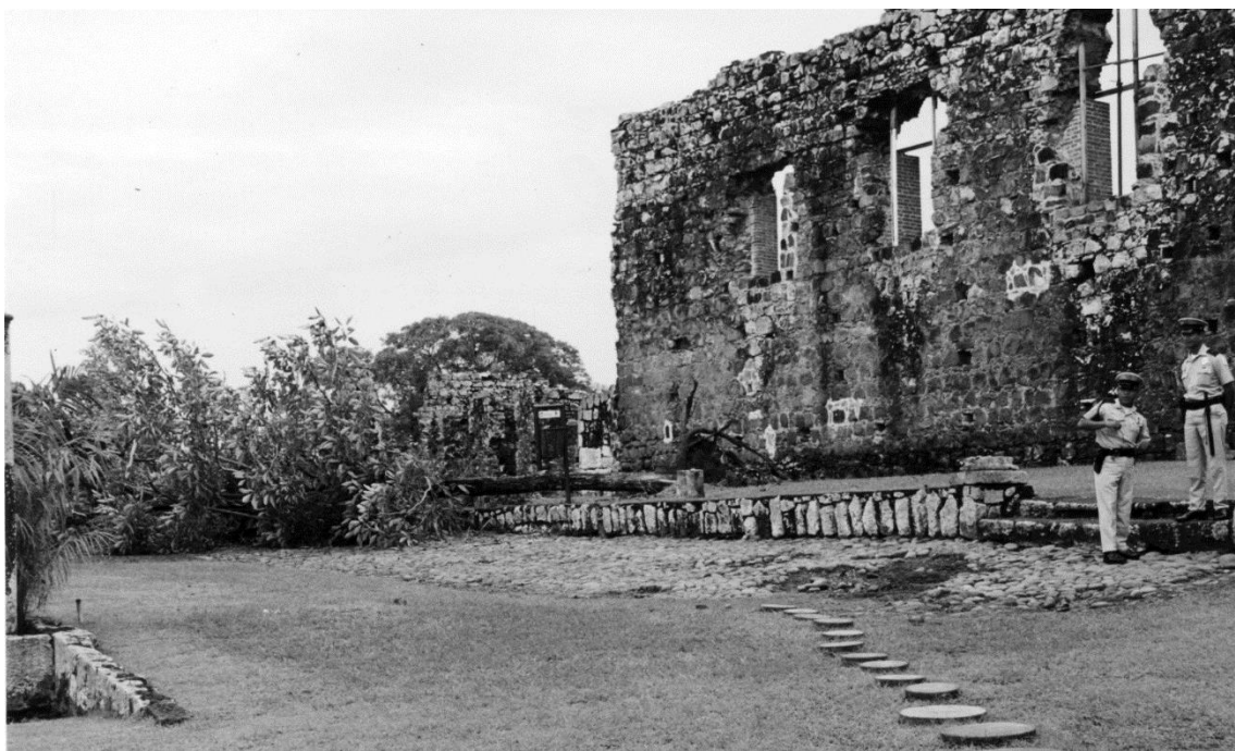
Figura 3.4. Imagen tomada del informe de los trabajos en el año 2000, aparece el árbol derribado y se pueden apreciar las características del atrio, delimitado por un murete de contención.
