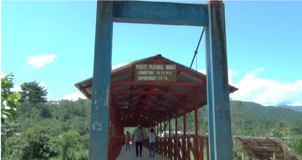
CCNN WAWAS - Puente de ingreso
