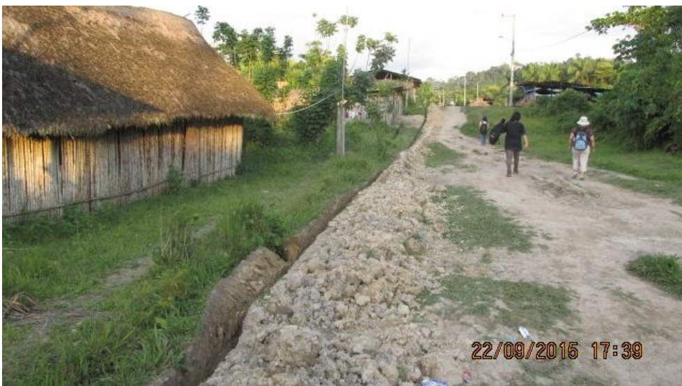
Ejecución de proyecto de agua potable en la comunidad
