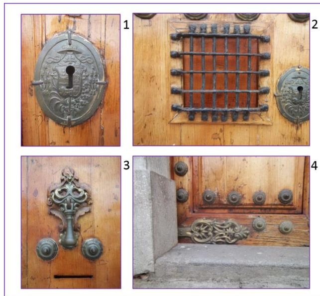
Imagen 163. Fotografías de detalles de los herrajes de bronce de la puerta principal del Palacio Arzobispal de la Nueva Guatemala. Trabajo de campo, 2013. 2531
