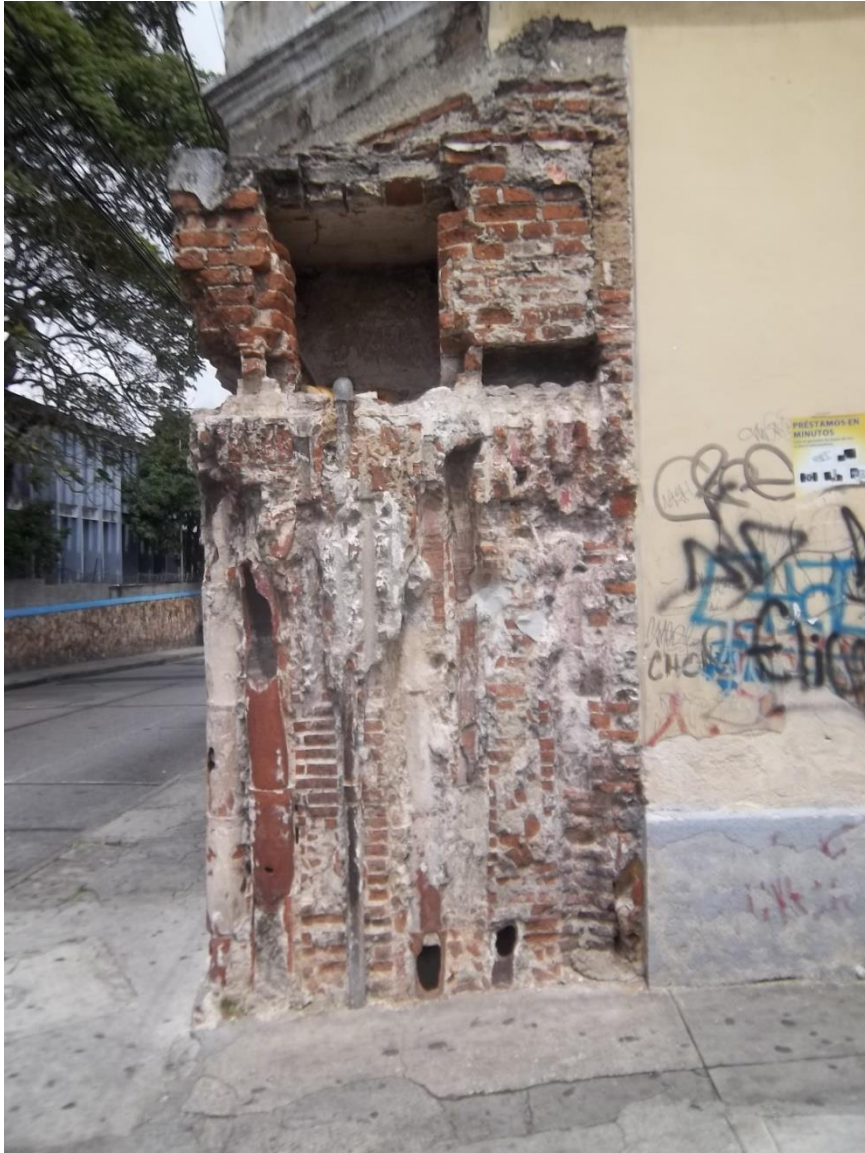
Imagen 71. Caja distribuidora en la décima calle. Cerca al AGCA. Trabajo de campo 2013. 1317
