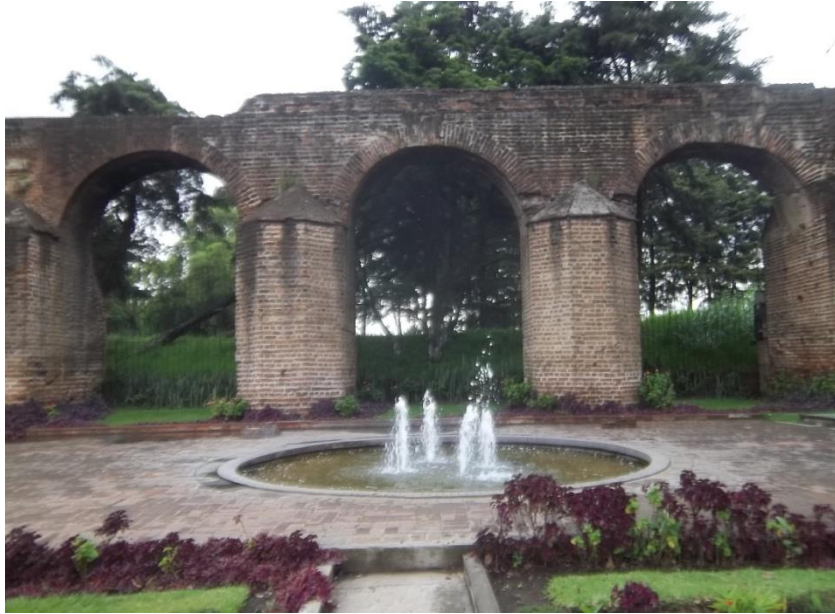
Imagen 70. Arquerías del acueducto de Pinula cerca al Zoológico y al Aeropuerto. Labor de campo 2013. 1316
