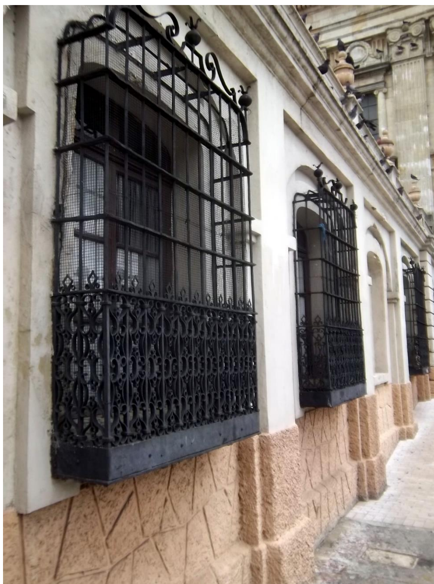
Imagen 166. Fotografía de la obra de herrería para la reja de las ventanas del Palacio Arzobispal. Trabajo de campo, 2013. 2533
