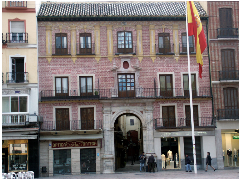
Fig. 7. Inmueble en la Plaza de la Constitución, Málaga
