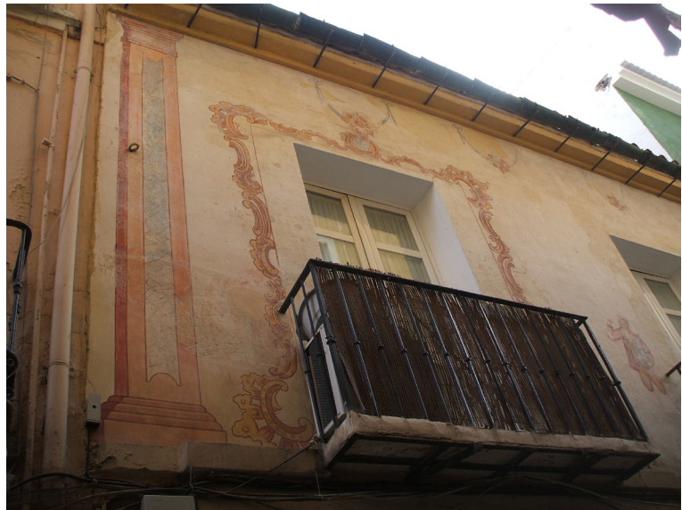
Fig. 5. Calle Nuño Gómez, nº 10, Málaga.
