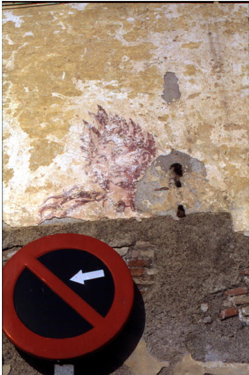
Fig. 3. Calle Pasillo de Atocha (Málaga). Detalle.
