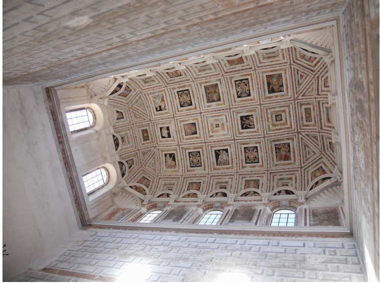
Fig. 1. Escalera del Hospital de Santiago, Úbeda (Jaén).
