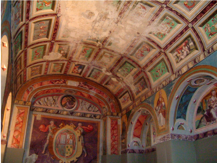
Fig. 3. Sacristía del Hospital de Santiago, Úbeda (Jaén).
