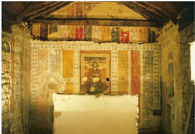
Fig. 6. Igreja de São Tiago de Adeganha, Torre de Moncorvo. Capela mor.
