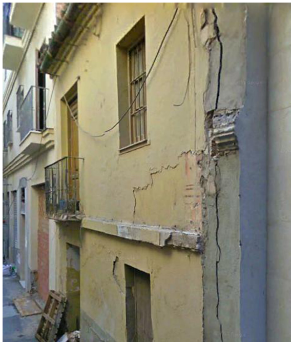
Fig. 4. Calle Nuño Gómez, nº 3, Málaga.
