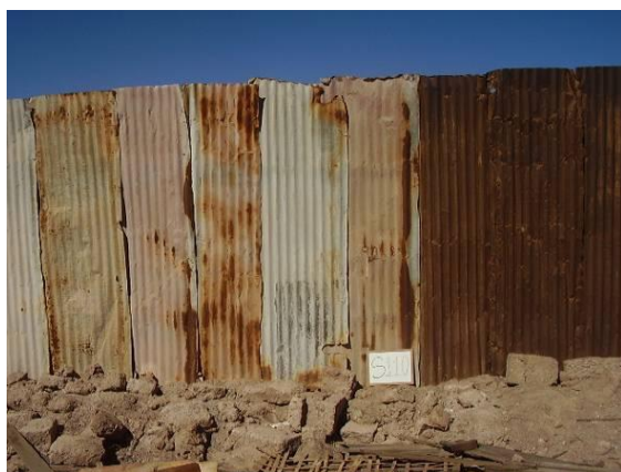
Detalle cierre con calaminas recicladas, 2009
