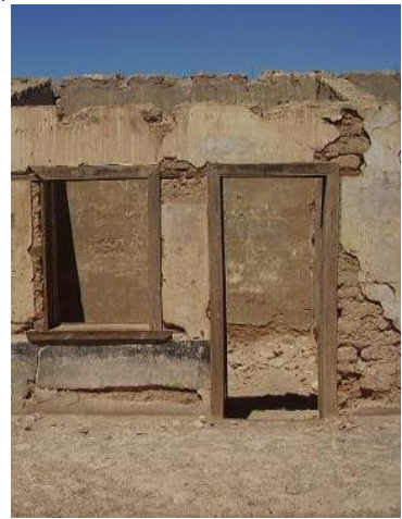
Estructuras sin cubiertas, 2009
