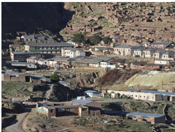
Vista a la ciudad minera de Pulacayo Fuente: giorgetta.ch
