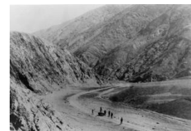
Cuadrilla trabajando en la Negra
