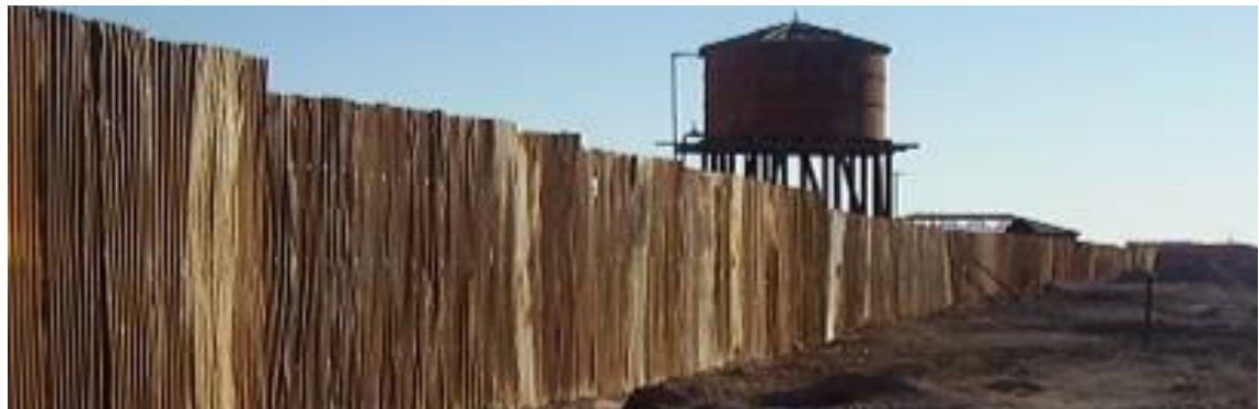
Cierro de madera y planchas de calaminas, exterior a Casas de Empleados Superiores, 2009
