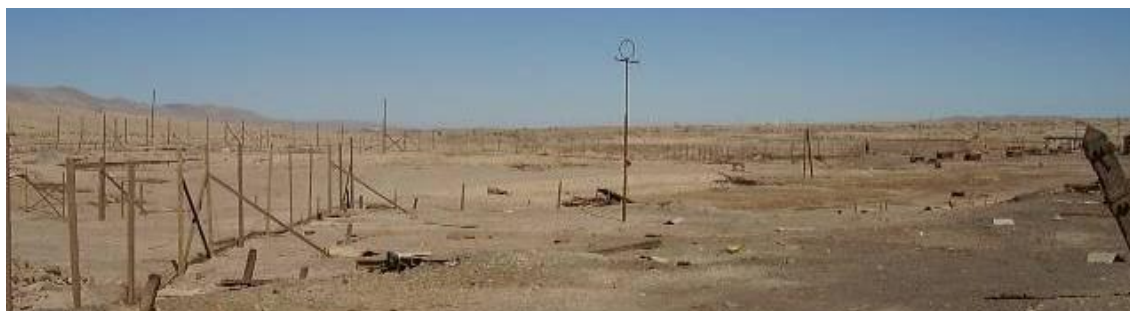
Cierros de madera, malla y alambre hacia el SSE del inmueble, 2009
