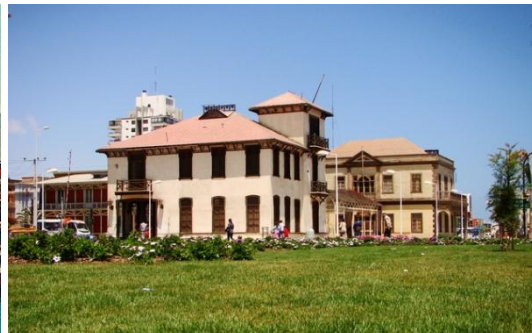
Resguardo Marítimo y Gobernación Marítima, estado actual
