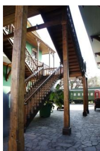
Escalera acceso piso 2
