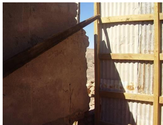
Encuentro muro de adobe y cierre nuevo, 2009
