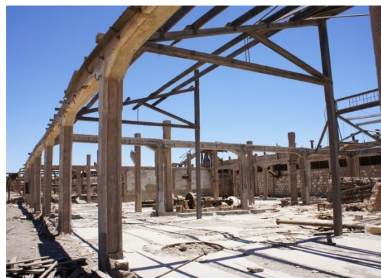
Marcos de hormigón armado y cerchas de madera, 2011
