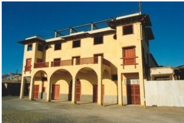
Teatro, primera fase restauración, 1992
