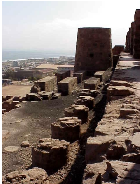
Estado de alteración y deterioro
