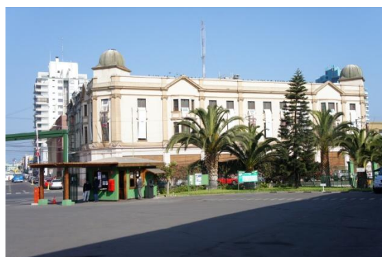
Casa Patiño, sede del nuevo Centro Cultural Estación Antofagasta
