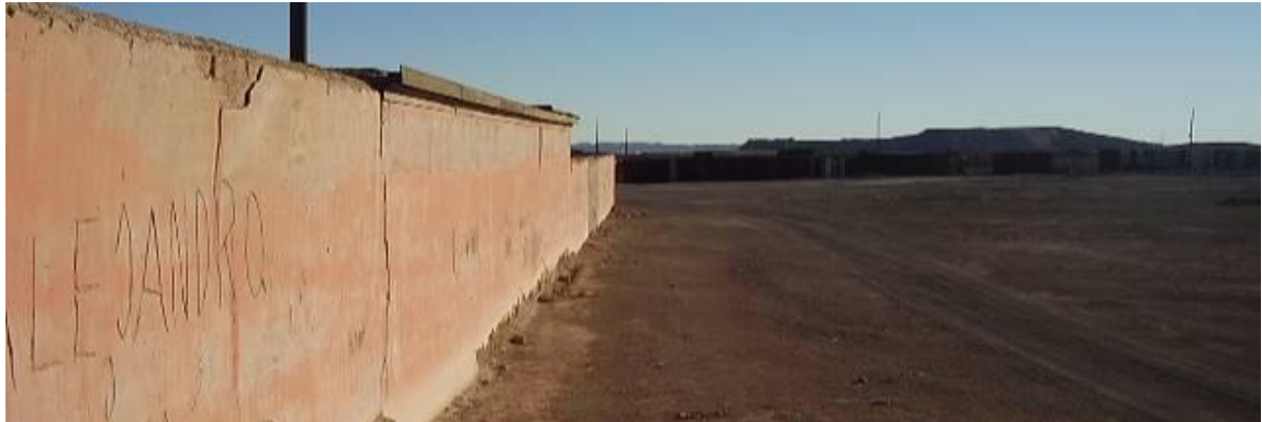
Muros de adobe, correspondientes al fondo de sitio del edificio Administración, 2009
