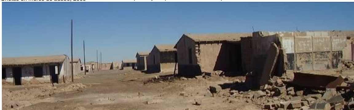
Asentamientos diferenciales de terreno y abatimientos de muros en calles, 2009
