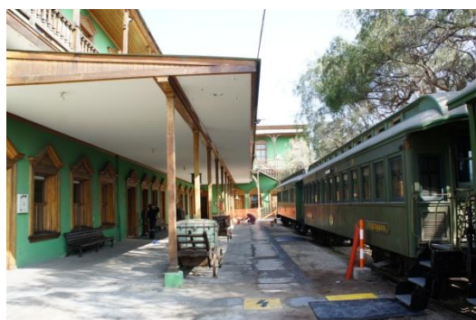
Andén de pasajeros, estado actual
