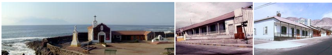
Sala de Máquinas, actual Capilla Militar Nuestra Señora del Carmen Casas Huanchaca-FCAB, actuales calles Av. Argentina y Maipú
