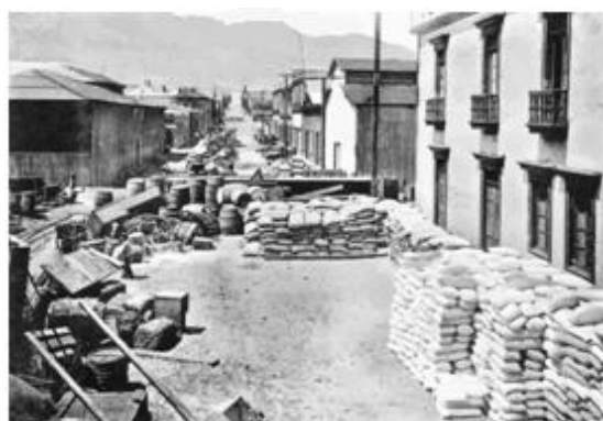
Sucre y Balmaceda desde el Malecón, cerca de 1900 Fuente: Adolfo Contador
