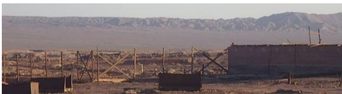
Cierros de madera, malla y alambre, que se unen al muro de adobe existente del antiguo Corral, 2009
