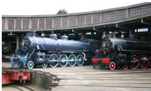
Casa de Máquina de Temuco.
