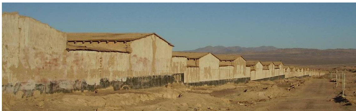
Muro de adobe conformado por casas de obreros hacia el perímetro SOO del conjunto. 2009
