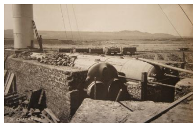
Calderos y base de chimenea, 1923 Fuente: Archivo Histórico UCN
