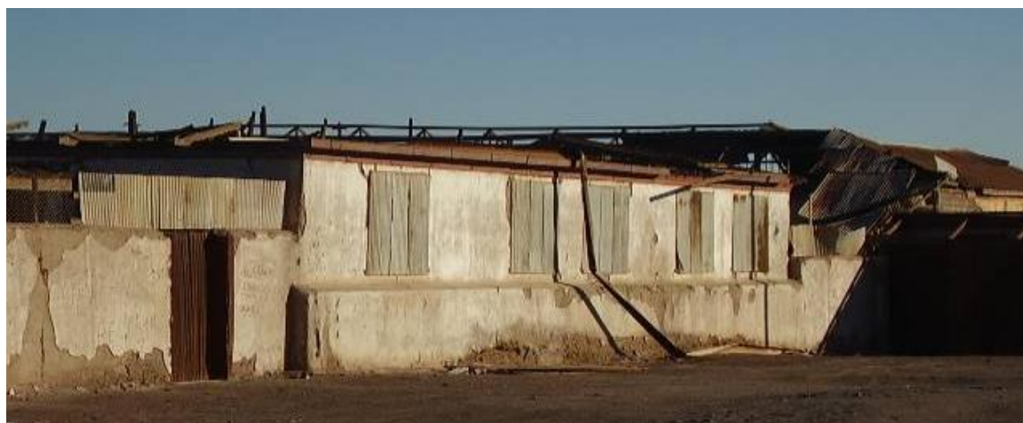
Muros de adobe de construcciones existentes con ventanas tapiadas
