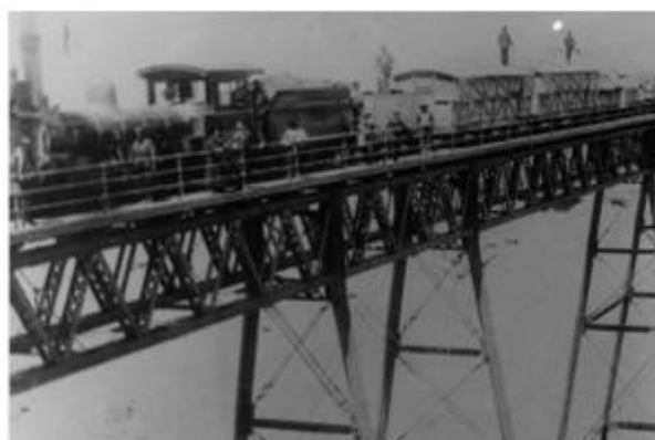
Puente Conchi, construido a fines del siglo XIX para el ferrocarril Antofagasta a Bolivia, sobre el río Loa Fuente: FCAB
