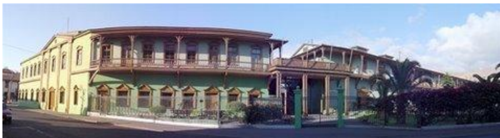
Conjunto edificios Ferrocarril de Antofagasta a Bolivia, 2010
