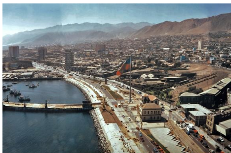
Costanera Central, 2011 Vista desde el sur
