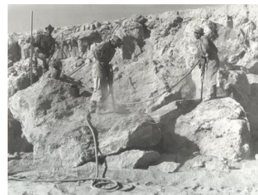
Perforación de bolones.
