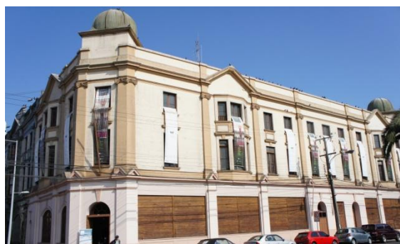
Casa Patiño-Hotel Belmont, habilitado como Centro Cultural
