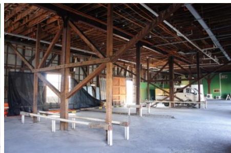
Estructura de soporte Oficinas (Estacionamiento)
