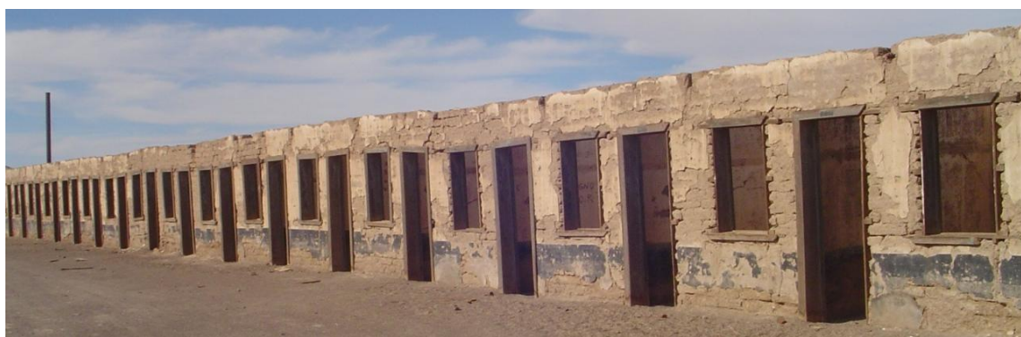
Muro formado por viviendas de solteros, al sur del inmueble, 2009
