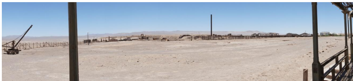
Panorámica del conjunto desde la Casa del Administrador
