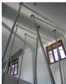
Contraste hormigón y acero
