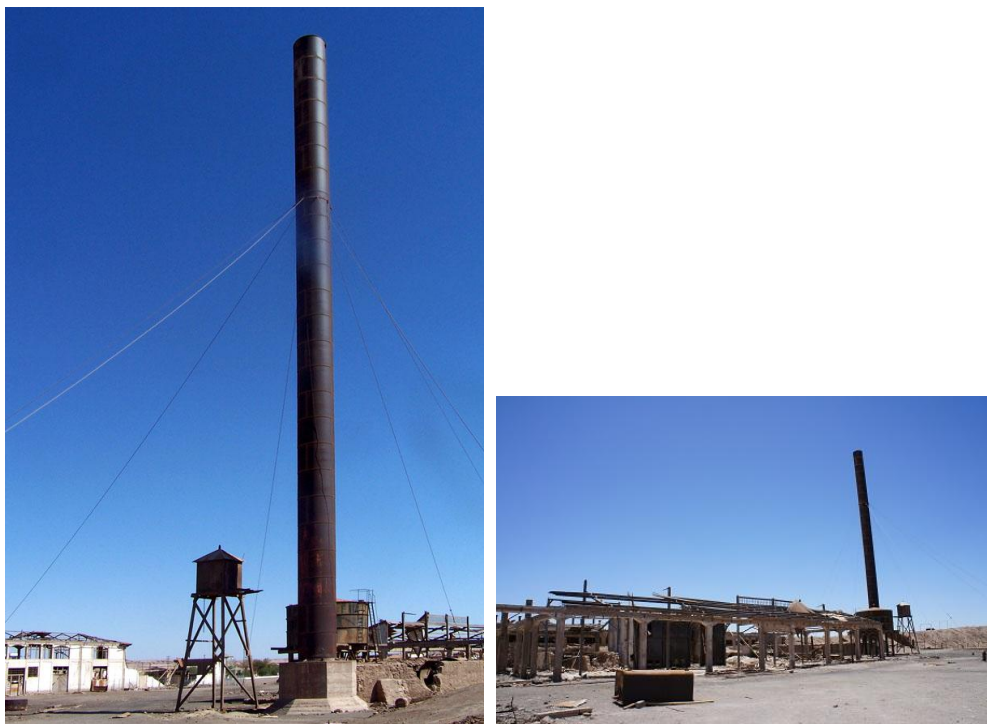
Chimenea, con sus tirantes de acero, 2009 y 2011 respectivamente
