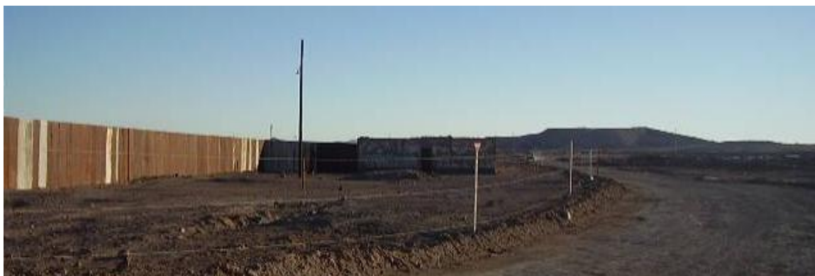
Cierro en base a estructura de madera y revestimiento de calamina, construido en 1992 a un costado del acceso actual, 2009
