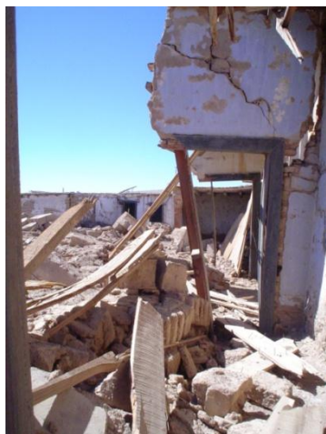
Fracturas y derribo de muros, 2009
