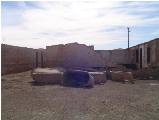
Tinas de cemento en el espacio público, 2009
