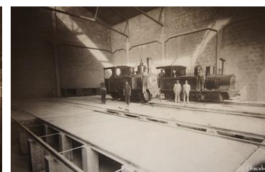
Casa de locomotoras, 1924
