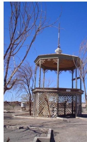
Construcción de ámbitos de sombra
