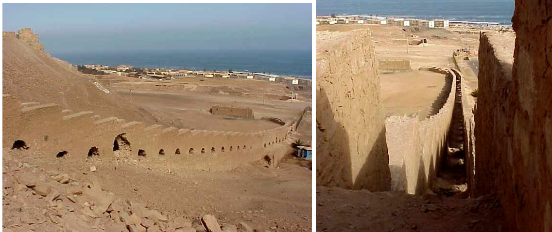
Estructura que soportaba el ducto de ventilación, que desviaba los vapores tóxicos y los eliminaba por la gran chimenea
