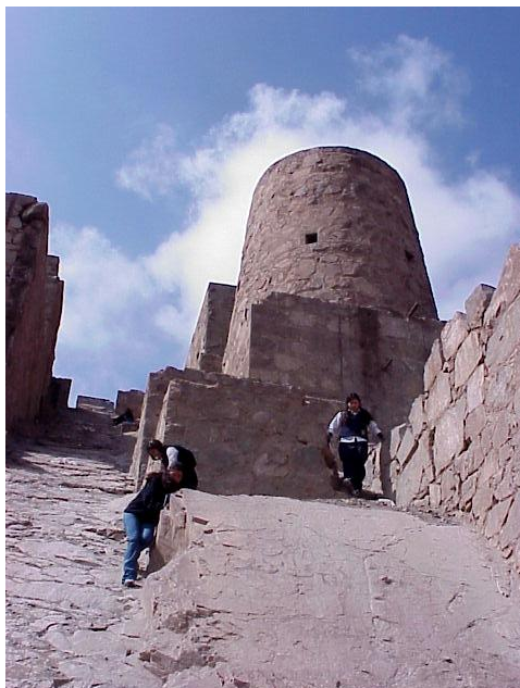
Caldera y muros de mampostería de piedra
