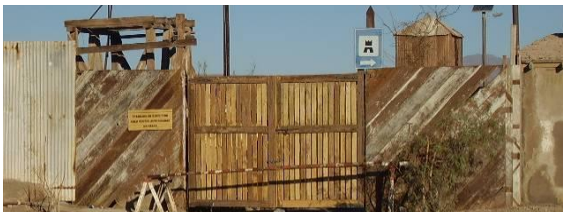
Actual portón de acceso al Monumento
