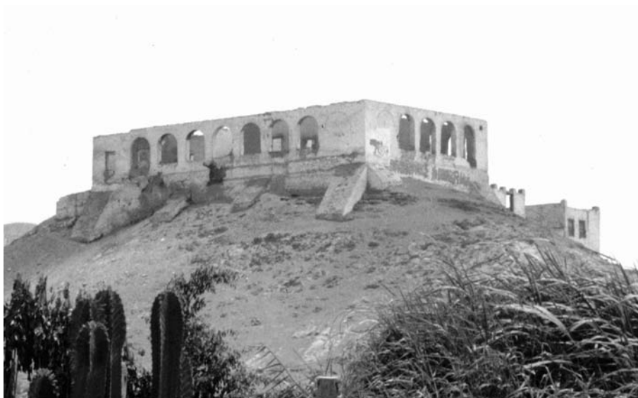
Casa principal de la hacienda Buenavista, estado actual. S. Negro, 2005.
