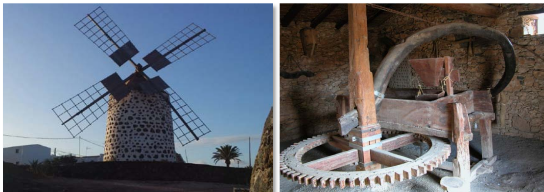
Figura 81. Molino rehabilitado (Lajares) y Tahona (Tefía).
