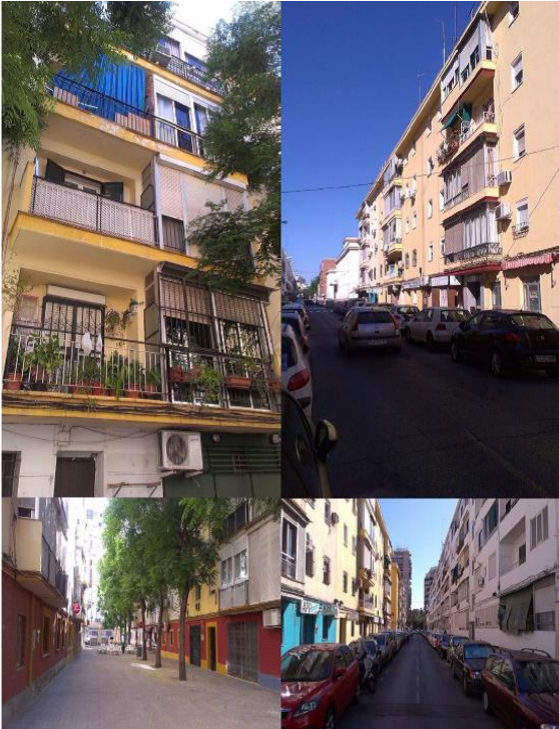
Imagen 4.7. La sección 3 de Los Remedios en imágenes
