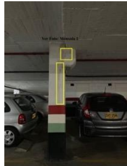
Ilustración 34. Acabados de ménsula SMO.
