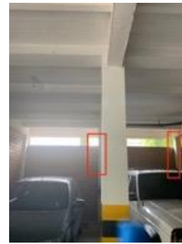
Ilustración 46. Columnas cortas VC.
