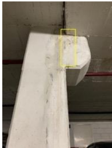
Ilustración 32. Acabados de ménsula SMO.
