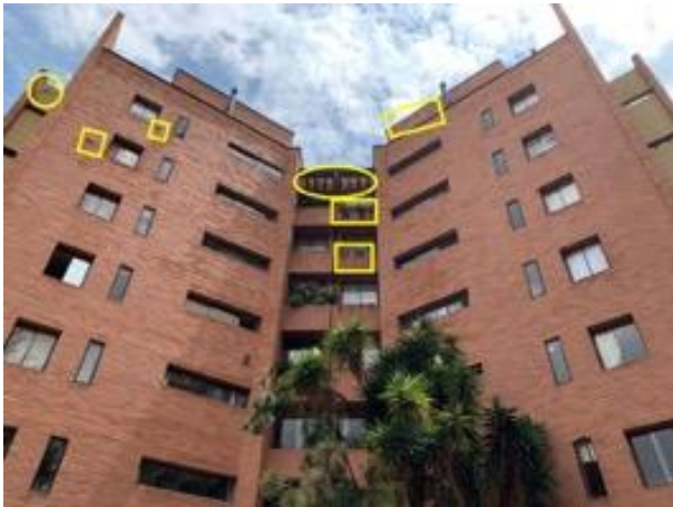
Ilustración 36. Fachada exterior edificio A.
