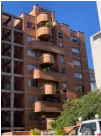
Ilustración 35. Fachada en buen estado SMO.
