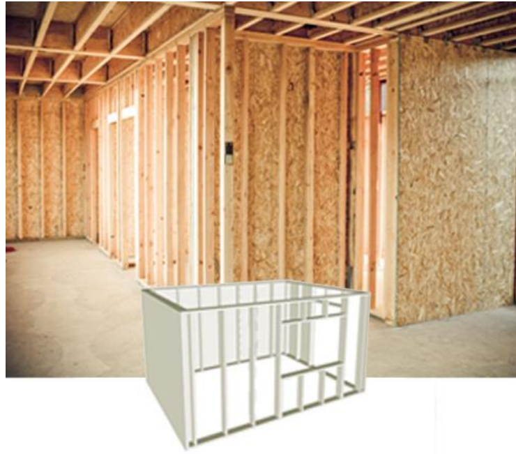
Ilustración 13, Entramado ligero en madera (CYPE Ingenieros, 2019).
