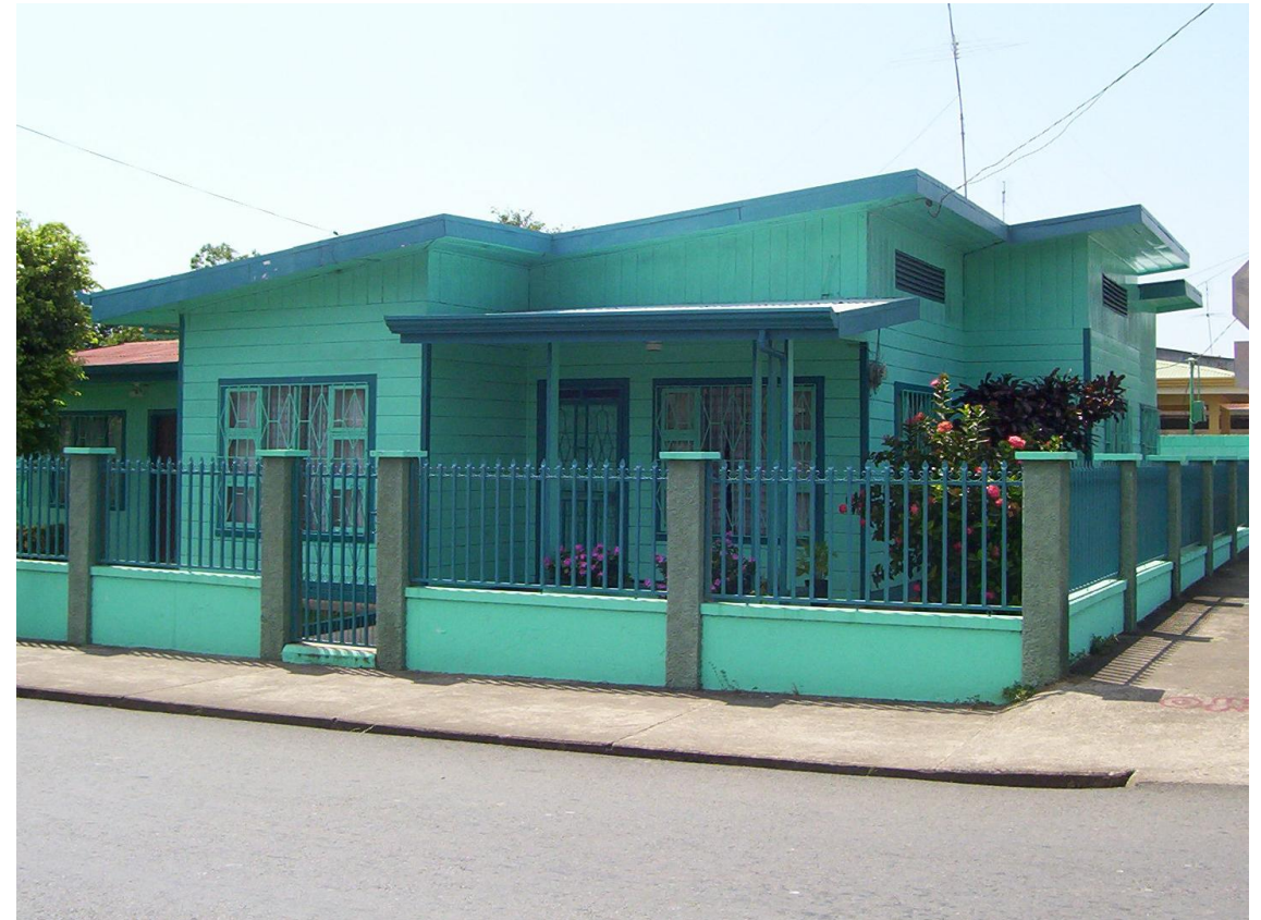
Imagen No 6. Vivienda Unifamiliar. Esparza, Puntarenas. 2006.
