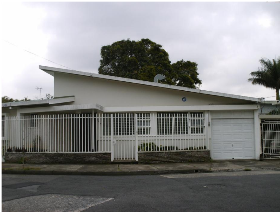
Imagen No 46. Movimiento Moderno. San José, San José. 2008.
