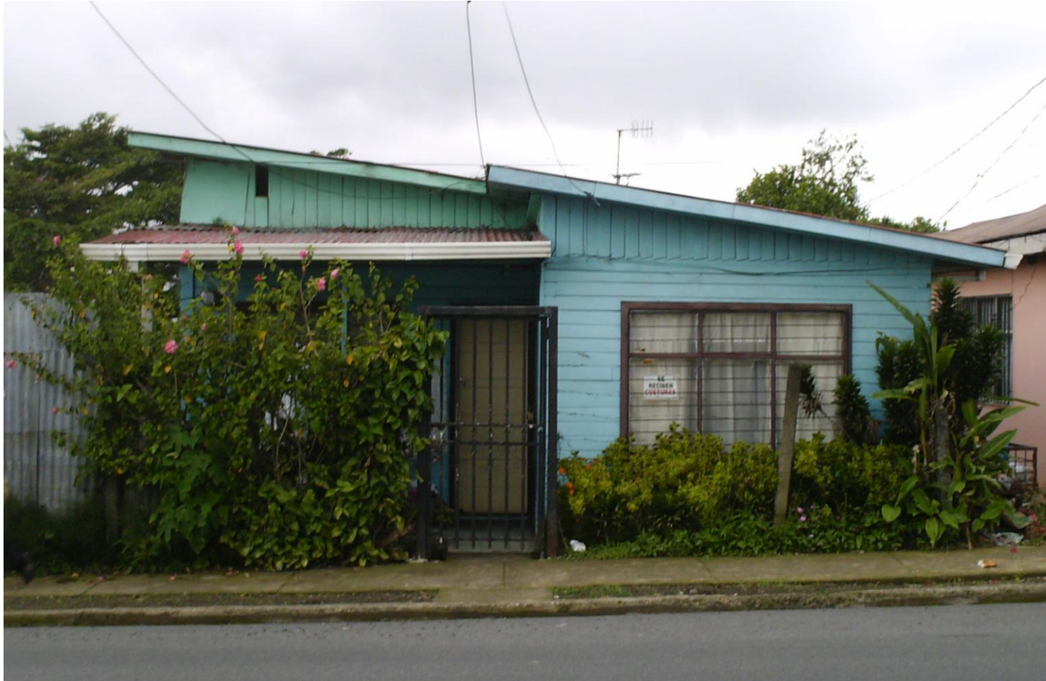
Imagen No 80. Vivienda María Elena Fallas . Montes de Oca, San José. 2008
