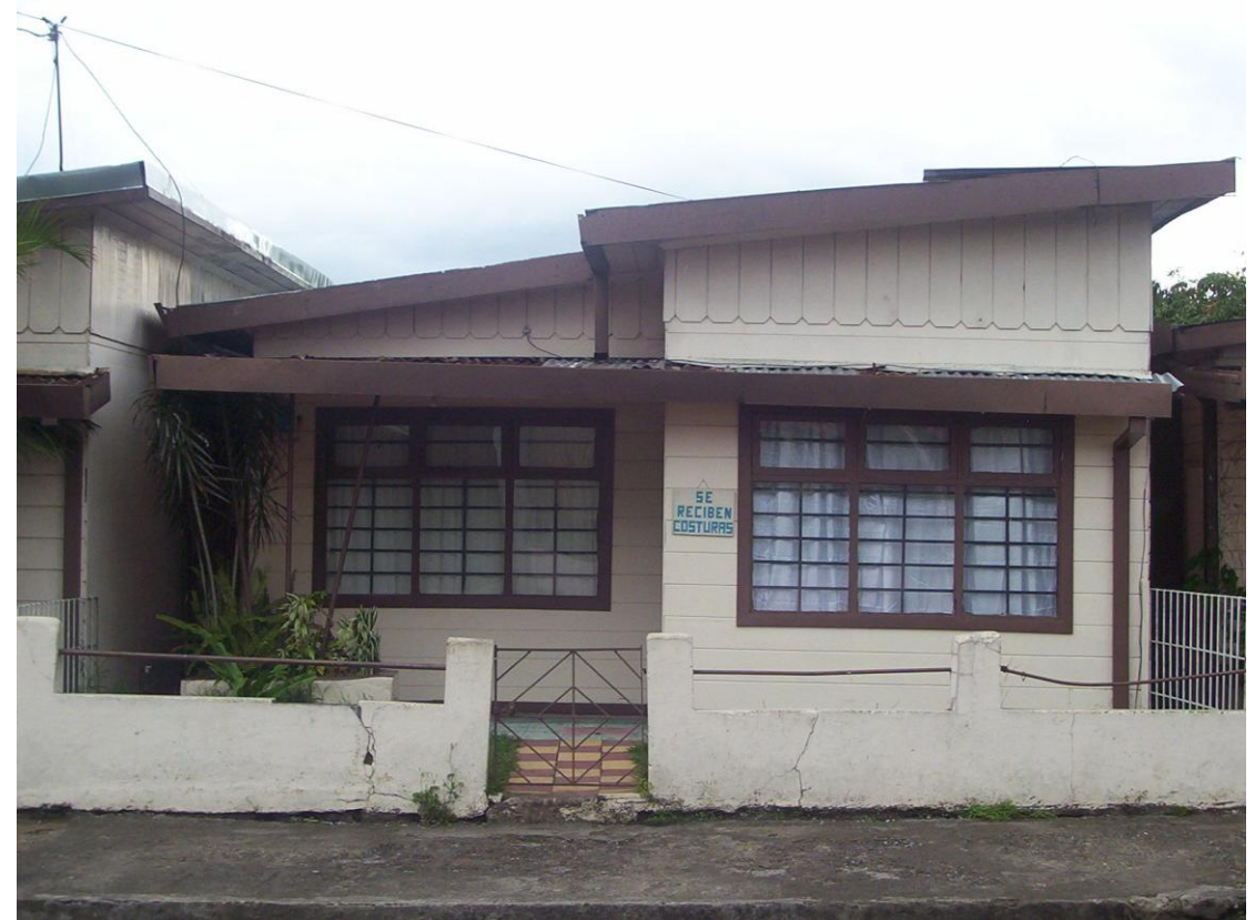
Imagen No 123. Vivienda Unifamiliar. Vivienda con alero protector sobre ventana.
