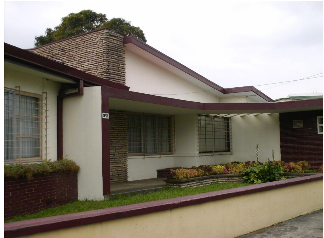
Imagen No 45. Movimiento Moderno. San José, San José. 2008.
