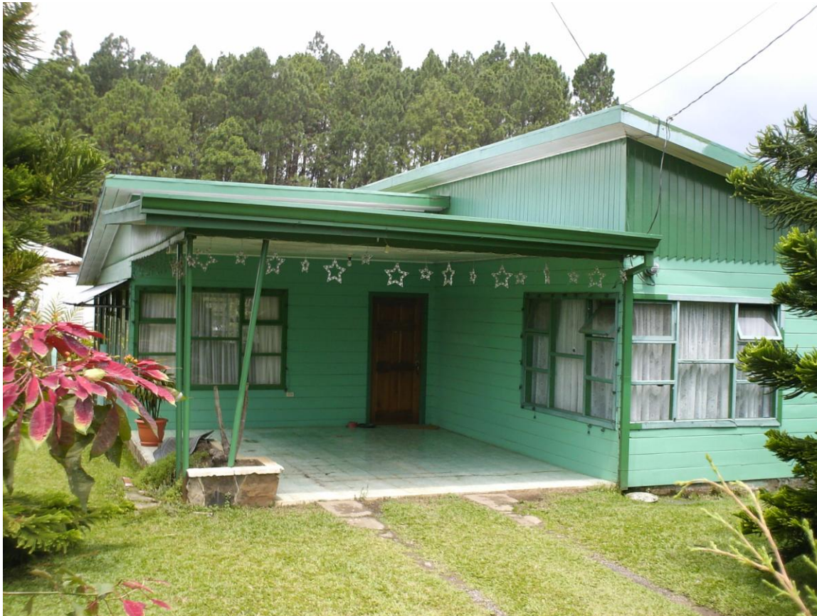
Imagen No 122. Vivienda Unifamiliar. Cubierta de tres variantes con confrontación en los aposentos de orden público. Vásquez de Coronado, San José. 2008
