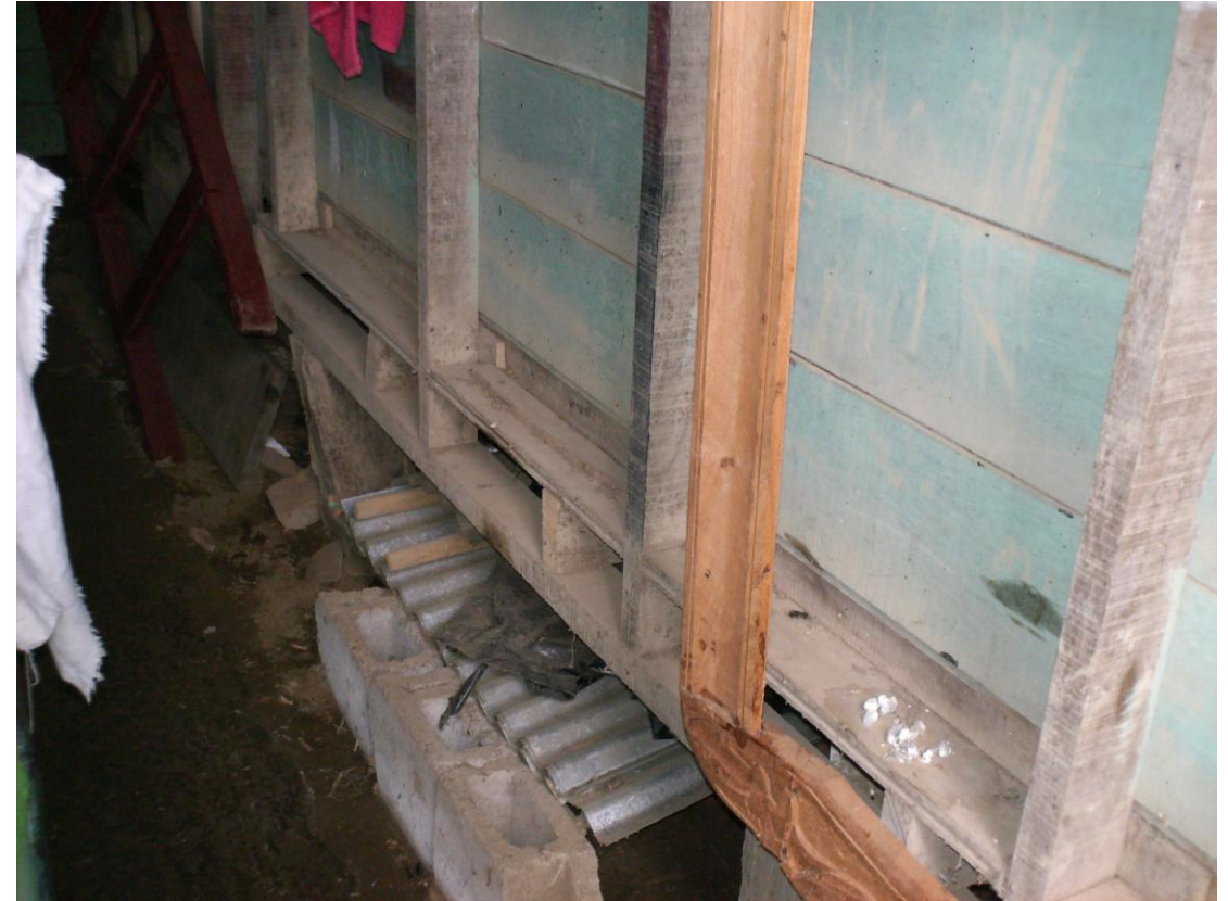
Imagen No 134. Vivienda Álvaro Picado . Estructura. Vásquez de Coronado, San José. 2008. Fuente: Personal.
