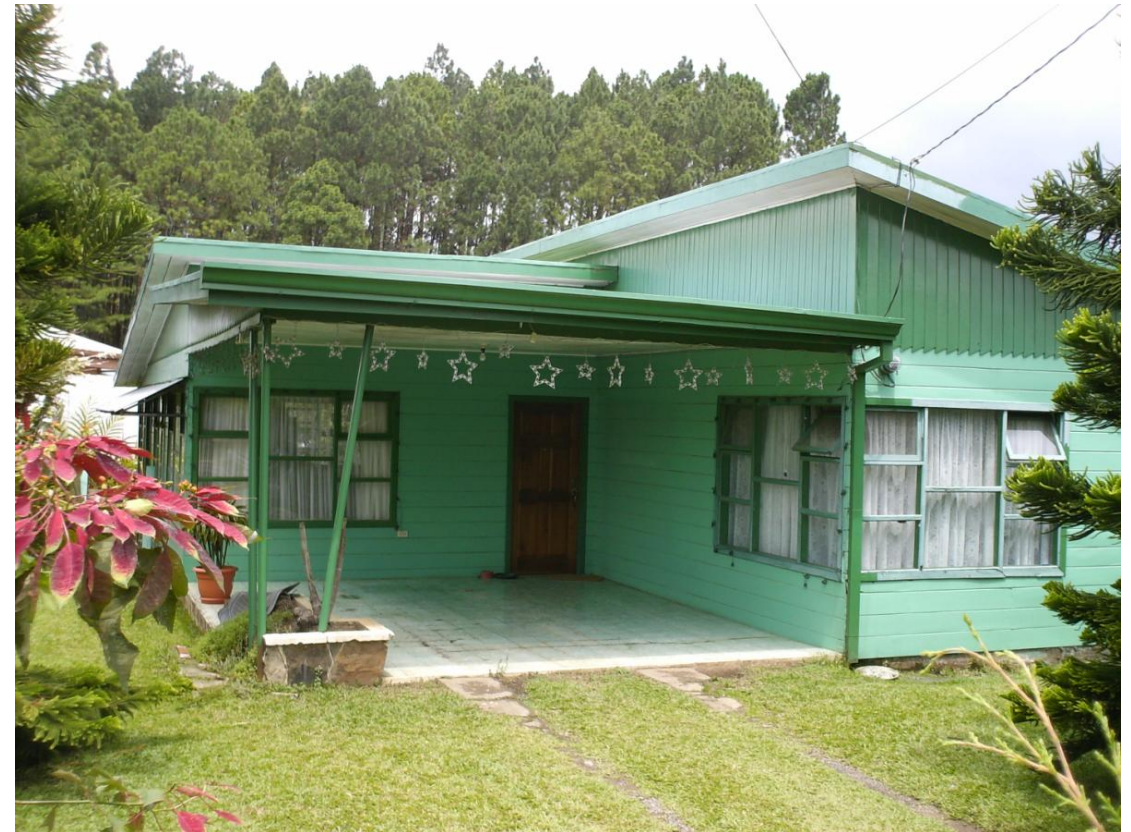
Imagen No 102. Vivienda Unifamiliar . Vásquez de Coronado, San José. 2008
