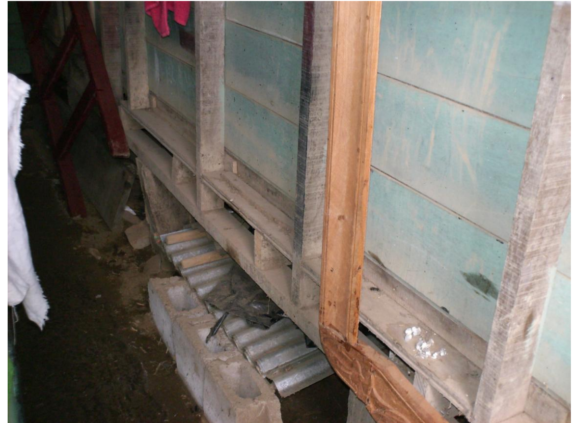
Imagen No 147. Vivienda Álvaro Picado . Estructura. Vásquez de Coronado, San José. 2008. Fuente: Personal.
