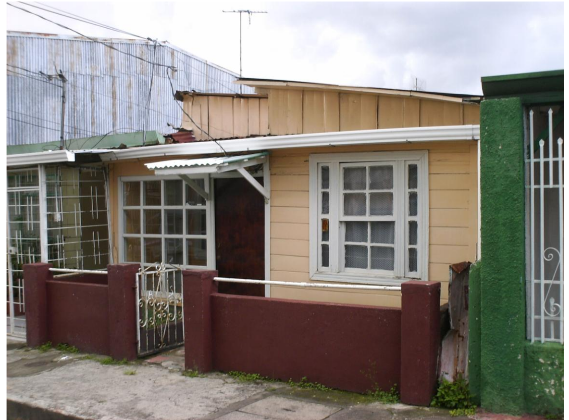
Imagen No 130. Vivienda Rafael Alvarado. Guarniciones en puertas, ventanas y esquinas. Goicoechea, San José. 2008. Fuente: Personal.
