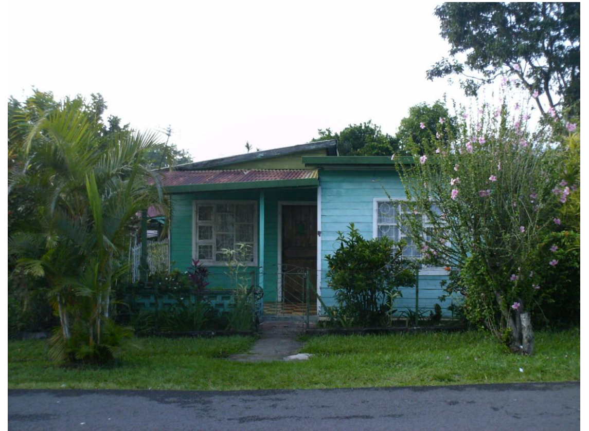
Imagen No 121. Vivienda Unifamiliar . Cubierta de tres variantes con confrontación en los aposentos de orden privado. Flores, Heredia. 2008
