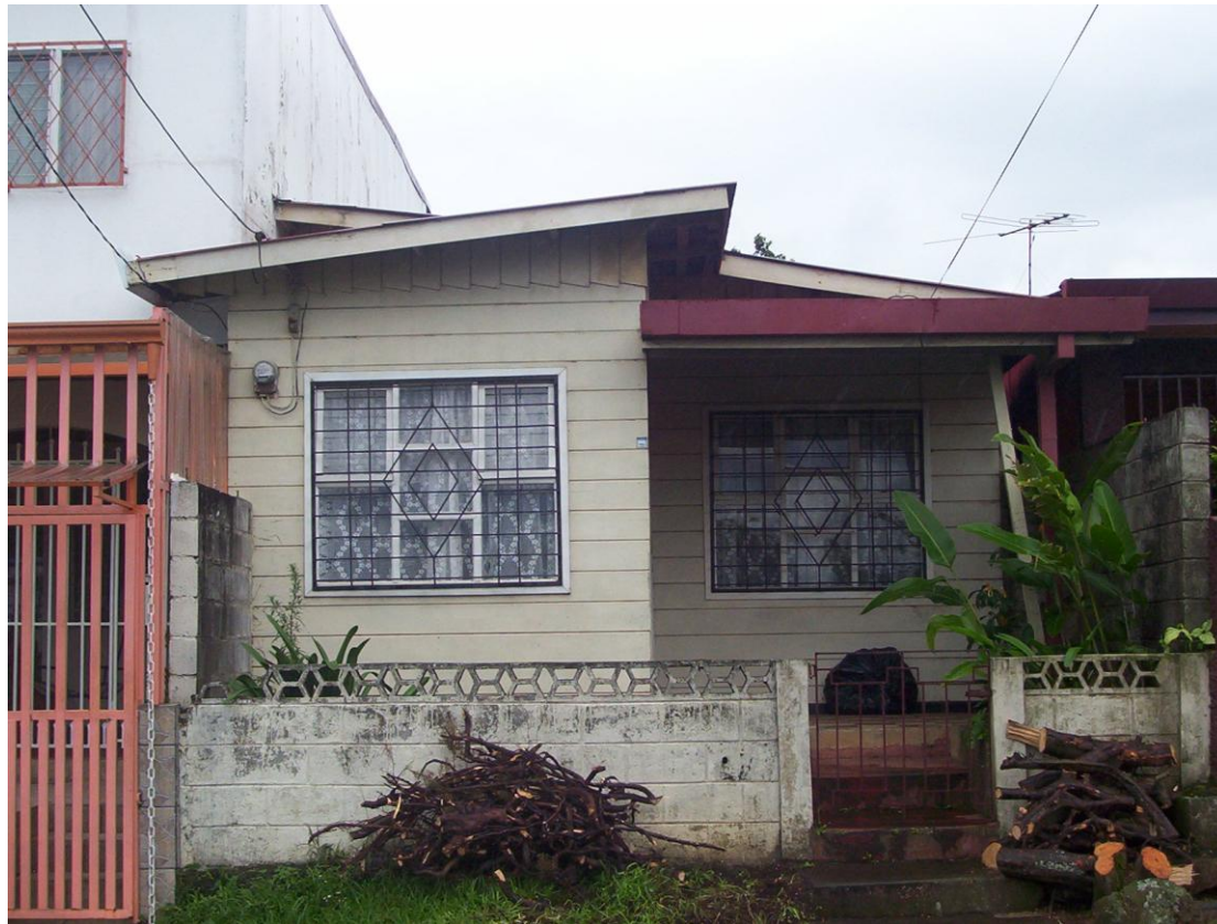
Imagen No 120. Vivienda Unifamiliar . Cubierta de tres variantes con confrontación entre los aposentos de orden público y privado. Barva, Heredia. 2006
