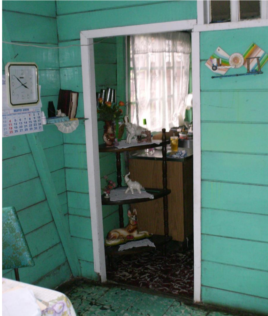
Imagen No 142. Vivienda Hermanos Bolaños . Detalle de Pared y Arriostre. Flores, Heredia. 2008. Fuente: Personal.
