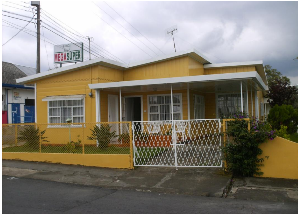
Imagen No 132. Vivienda Arcelly Villalobos . Detalle tapicheles madera con sección inclinada. Heredia, Heredia. 2008. Fuente: Personal.
