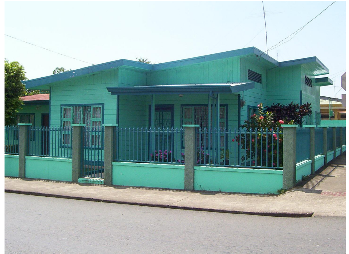
Imagen No 146. Vivienda Unifamiliar . Esparza, Puntarenas. 2006.
