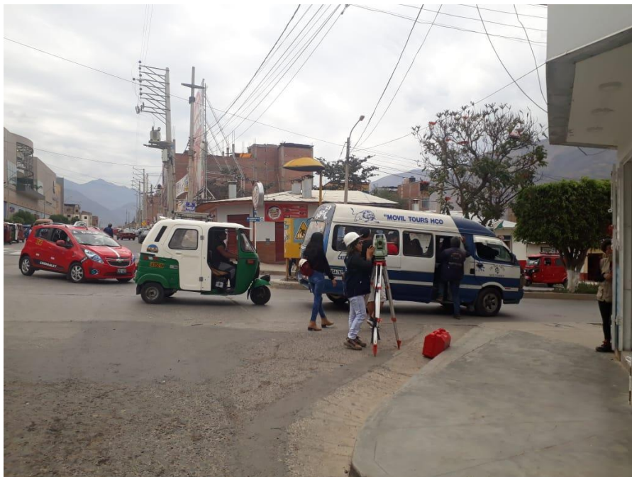
Figura 21: Estación LEICA modelo TS06. Fuente: Elaboración propia.
