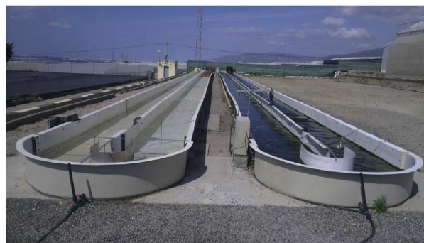
Figura 1: a) Reactor abierto.
