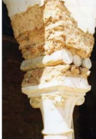
Figura2. Aislamiento sísmico compuesto por troncos de madera entre la columna y la arcada (2020).
