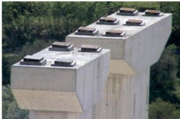
Figura 3. Apoyo elastómero (2020). (S. f.). [Ilustración]. Verdú - The global rubber technical service. Tomada de <http://www.cauchoverde.com/pag/es/5/apoyos-elastomericos-y-pot>
