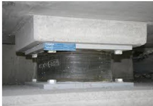
Figura 8. Aislador de Alto Amortiguamiento LASTO®HDRB (2020). (s. f.). [Ilustración]. mageba. Tomada de <https://www.mageba-group.com/global/data/docs/es/2573/PROSPECT-LASTO-HDRB-int-es.pdf?v=1.1>
