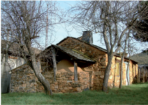
▪ Fig. 12. Los hornos se protegen de la intemperie por cobertizos levantados sobre pies derechos y ubicados en el corredor, en un caso y, en el otro, apoyado en una base cuadrada de piedra .
