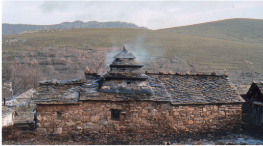
▪ Fig. 9. Chimenea troncopiramidal, cuarteada por el peso de los años, de tres cuerpos o pisos con remate piramidal sostenido, como las anteriores, por cuatro tacos de piedra.
