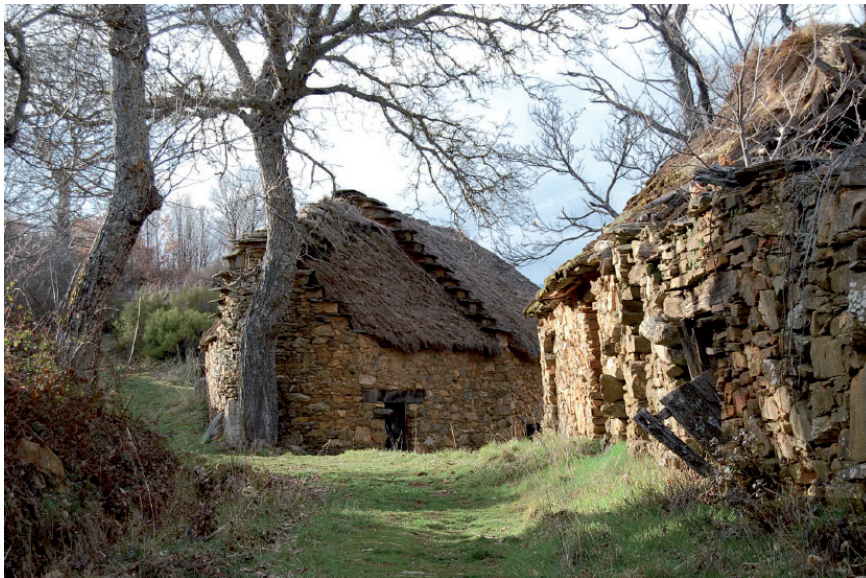
▪ Fig. 14. Geometría con trazados de fuertes pendientes que facilitan la evacuación rápida del agua y la nieve.
