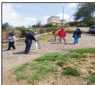
Figura 6. Levantamiento topográfico altimétrico.
