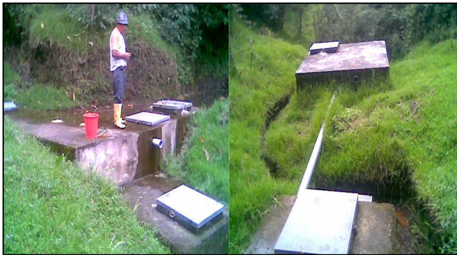
Figura 15. Sitio de captación de varias vertientes (La Joya I).
