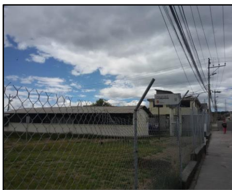
Figura 13. Instalaciones del subcentro de salud de Cutuglagua.
