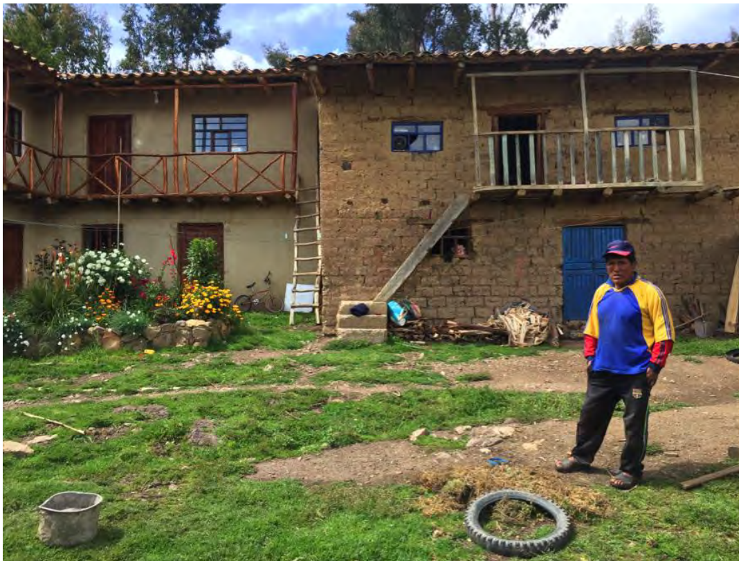
Imagen 50: Casa de Nicasio Pérez. Su vivienda presenta dos casas construidas claramente diferenciables. A la derecha de esta imagen, detrás de Nicasio, se encuentra la casa que él y su familia utilizan para dormir en el segundo piso. El primer piso de esta sirve para guardar herramientas y productos agrícolas. La otra casa es la que él ha construido para turistas. Nótese la presencia de flores, los acabados del balcón, el tarrajeo de las paredes. Nicasio tiene una casa mejorada tipo común para su uso personal al lado de una casa para turistas que no se encuentra en uso. Esta casa tiene camas, colchones y frazadas; sin embargo, nunca ha sido utilizada por turistas. Esta casa sólo ha sido utilizada una vez por un grupo de familiares de Nicasio que vinieron para un matrimonio de Cusco. Foto del autor.
