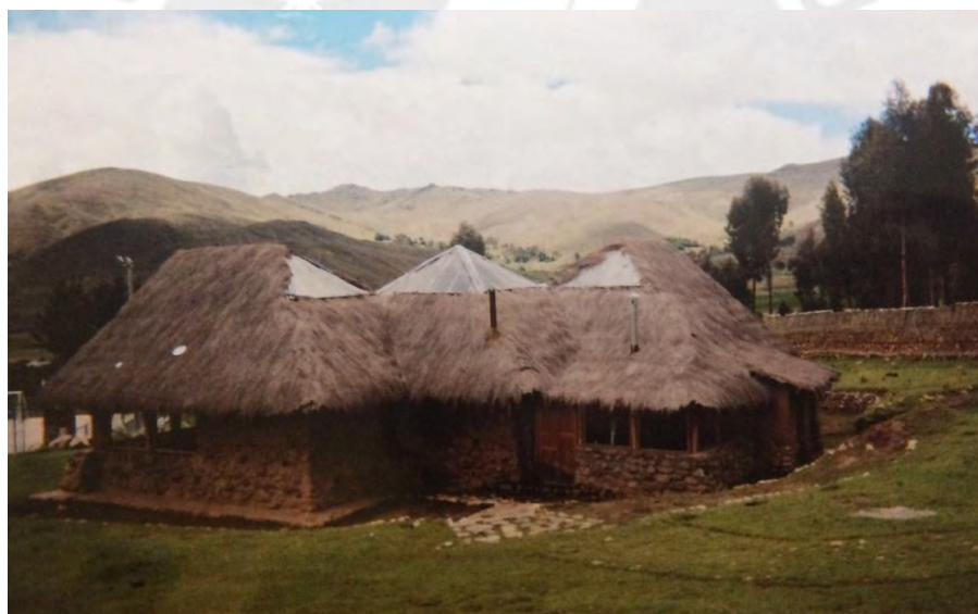
Imagen 44: Restaurante "Papamanka". A pesar de no ser una casa propiamente dicha, es considerada dentro de la tipología como una casa para turistas. Se trata de la construcción más valorada en la comunidad por los materiales utilizados y las formas que presenta. Los comuneros consideran que muchos turistas visitan el Parque por que el restaurante resulta muy atractivo para ellos. Foto: Walter Ylla.
