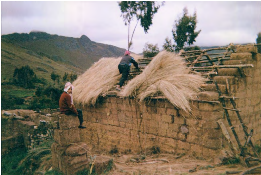
Imagen 25: Techando una casa tipo antigua con paja en el sector de Uyucate. Foto del autor.
