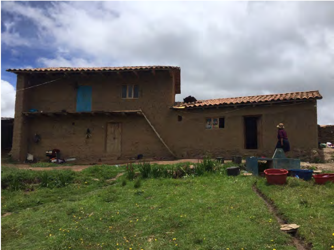
Imagen 31: Casa tipo común. A pesar de tener dos pisos y una cocina inmediata, esta casa pierde su valor en comparación a los otros subtipos de casas mejoradas debido, en parte, por la falta de tarrajeo, es decir, por dejar el adobe expuesto. Foto del autor.
