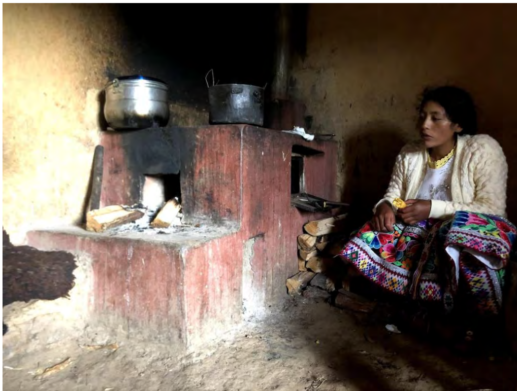
Imagen 9: Cocina mejorada de Luisa Ccoyo y Hermógenes Baca. La construcción del fogón tiene una tecnología que concentra el calor del fuego de leña y un tubo que funciona como chimenea para que el humo salga del espacio de la cocina. Esta cocina mejorada a pesar de haber sido instalada muy recientemente (2016) y tener menos de un año de uso, no funcionaba del todo bien, ya que, el humo del horno se escapaba y no iba directo hacia el exterior. Un rastro de esto son las paredes ennegrecidas. Foto del autor.
