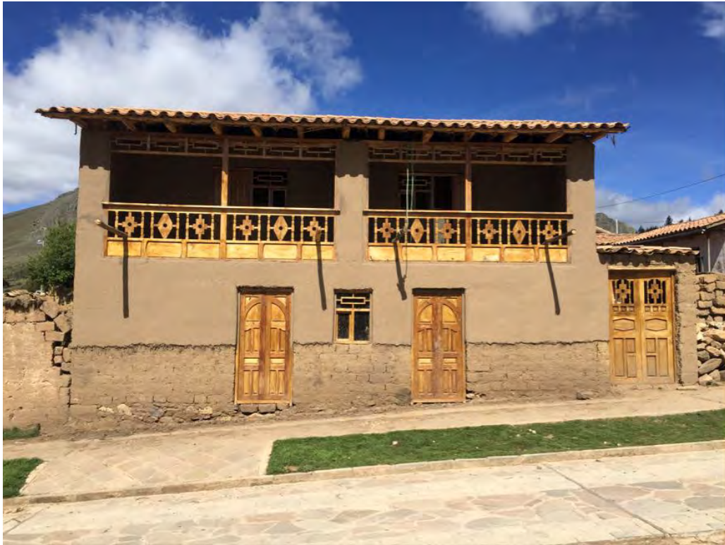
Imagen 42: Casa para turistas en construcción. Nótese los detalles de los balcones de madera con figuras de rombos y chakanas. Foto del autor.
