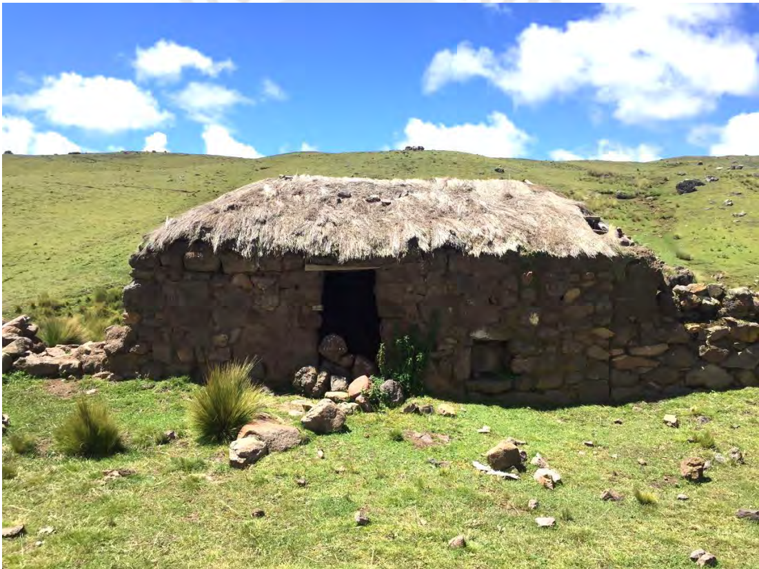
Imagen 27: Casa de piedra con techo de paja. Sin uso. Foto del autor.
