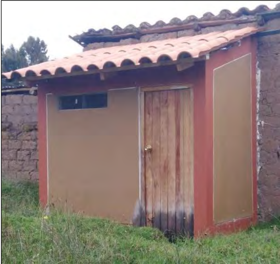
Imagen 21: Vista exterior de un baño digno. Foto Víctor Ylla.
