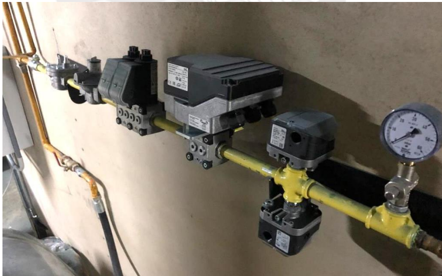
Figura 6.5: Elementos constituyentes del control para la alimentación de gas.
