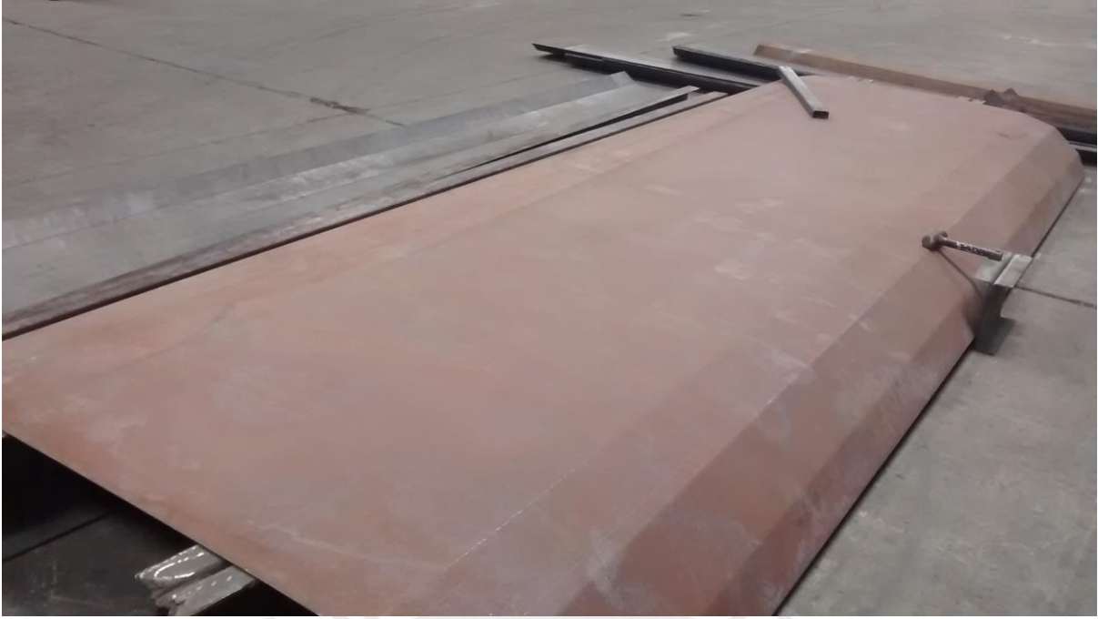
Figura G5. Unidad a la espera de canales verticales para la base de tolva.
