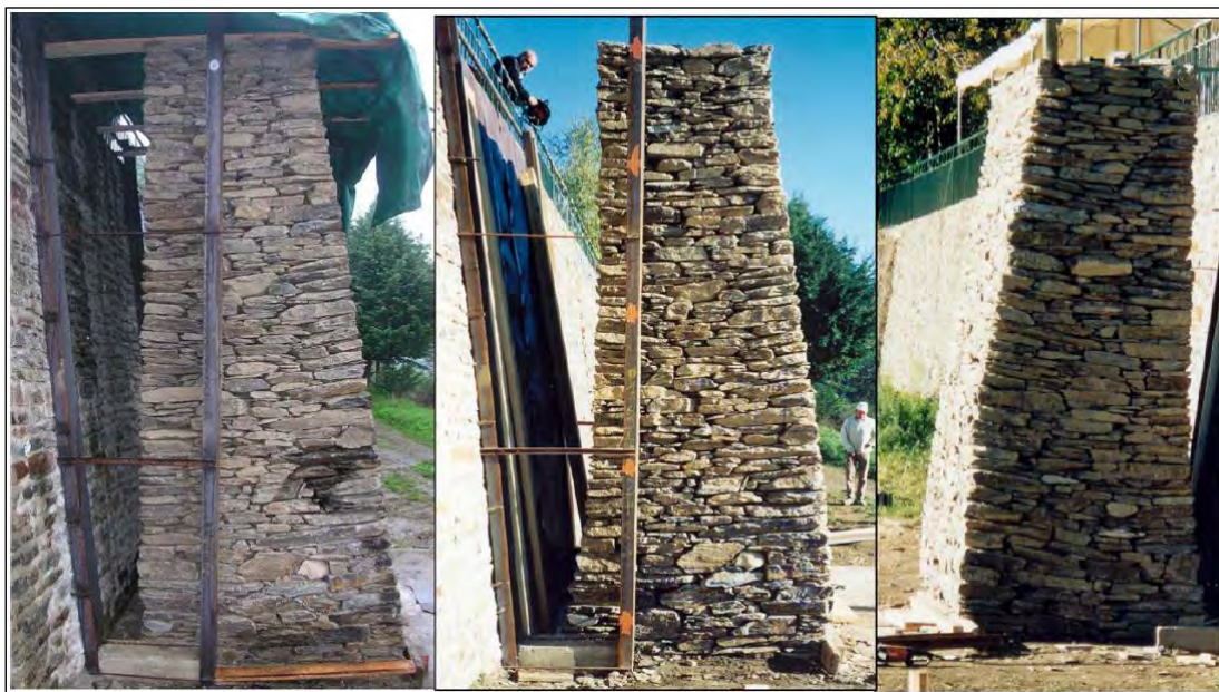
Figura 6. Ensayo de un muro de piedra de junta seca mediante fuerzas hidrostáticas (Villemus et al., 2007)
