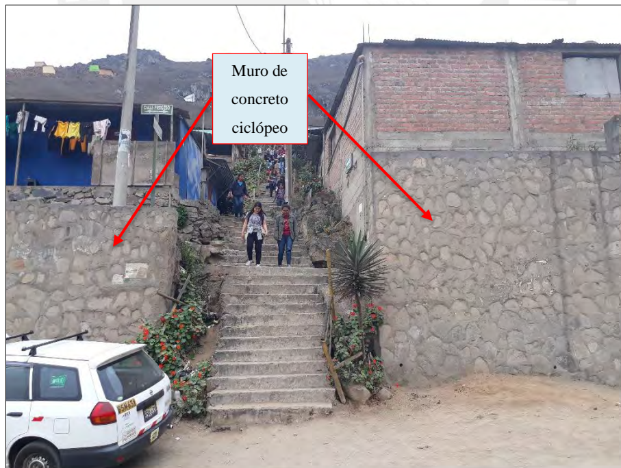
Figura 3. Muro de concreto ciclópeo – distrito de Villa María del Triunfo
