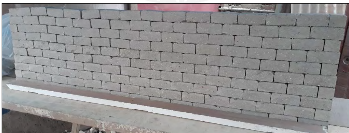
Figura 29. Muro de adoquines (bloques regulares)
