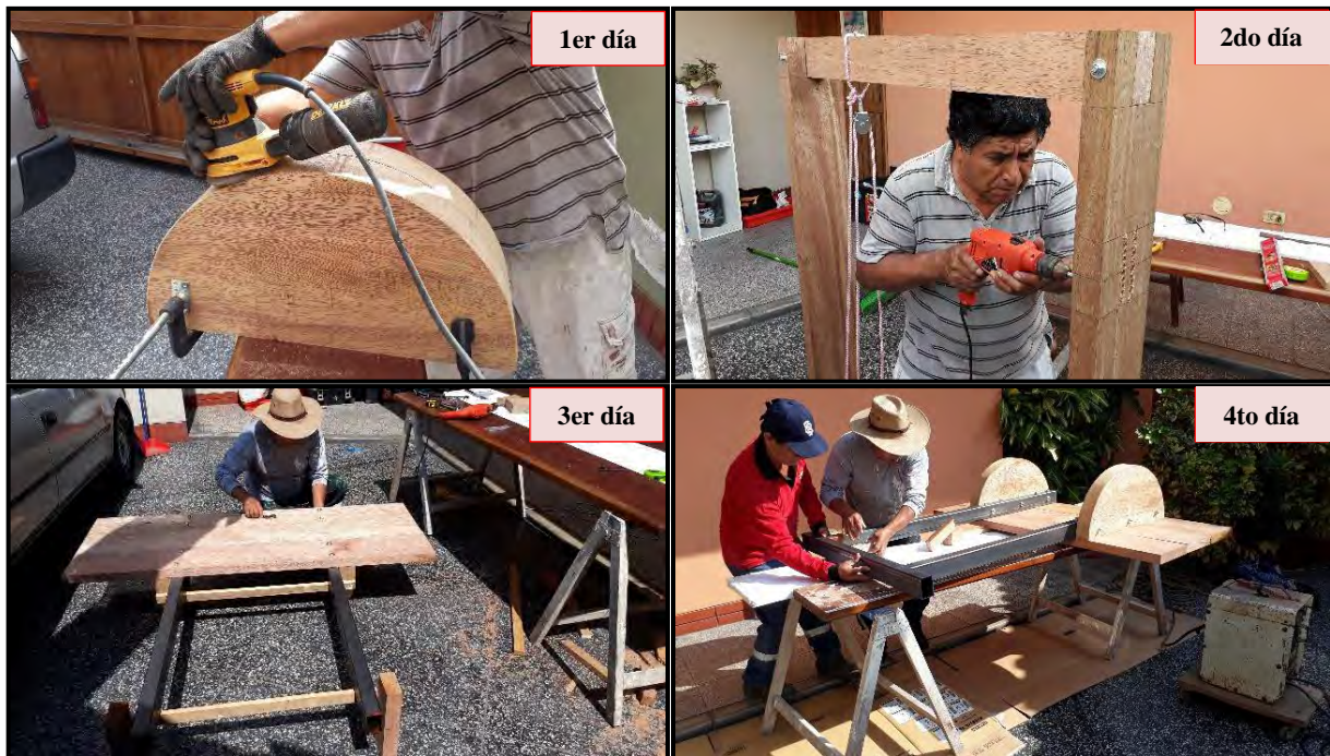
Figura 26. Proceso constructivo del equipo, cada foto corresponde a un día diferente
