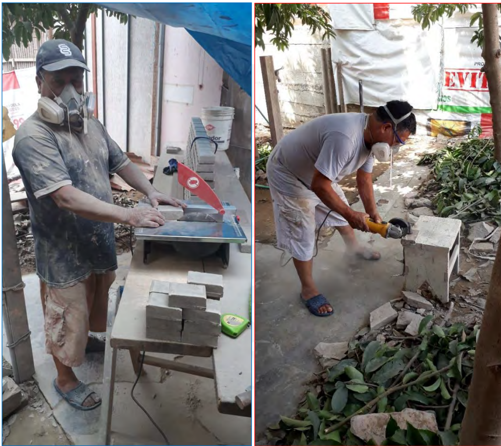
Figura 34. Elaboración de las piezas: a la izquierda, los bloques regulares; y a la derecha, los irregulares
