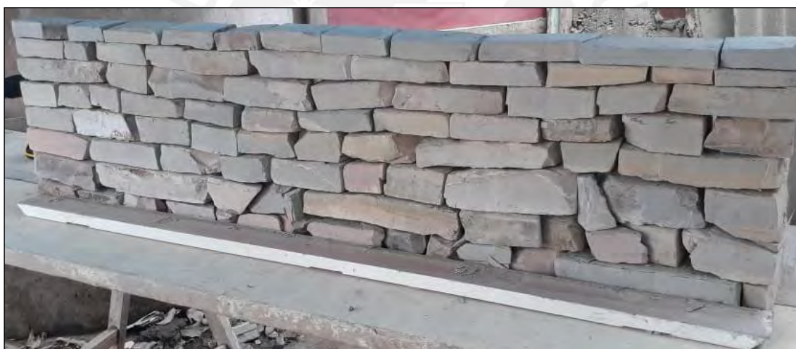
Figura 30. Muro de piedras (bloques irregulares)
