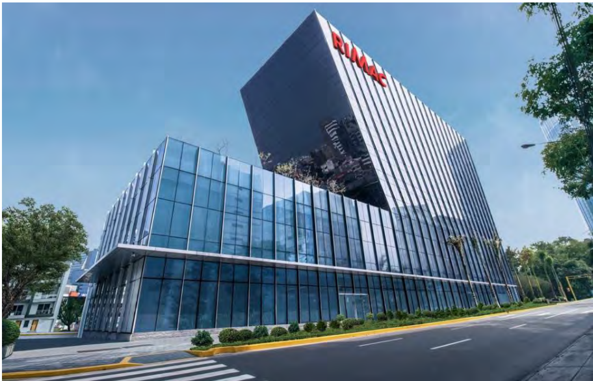
Figura 18. Vista exterior de Torre del parque en Calle las Begonias, San Isidro.
