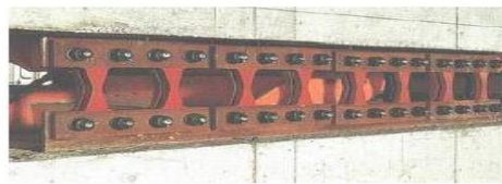
Figura 2. 10. Amortiguamiento Honeycomb. (Hanson et al., 1993)
