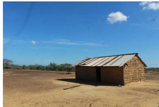
Figura 4. Construcción de vivienda en la Península de La Guajira a la altura de la ranchería Wourre.
