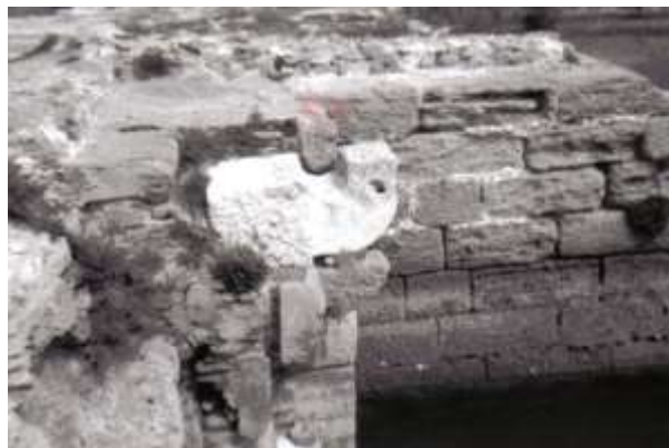
FIGURA 15 MÉNSULAS DE APOYO DE LAS COMPUERTAS. MOLINO DE SAN JOSÉ.
