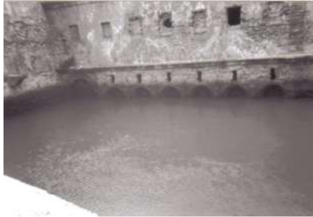
FIGURA 22. CANALES DE DESAGÜE. MOLINO DE RÍO ARILLO
