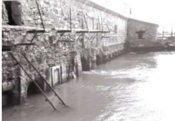
FIGURA 26. COMPUERTA DEL SAETILLO. MOLINO DE RÍO ARILLO.
