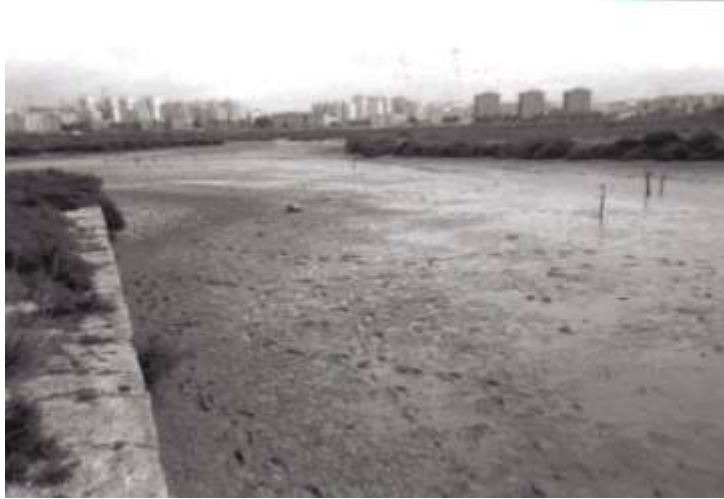
FIGURA 9. MURO DE LA CALDERA. MOLINO DE SAN JOSÉ
