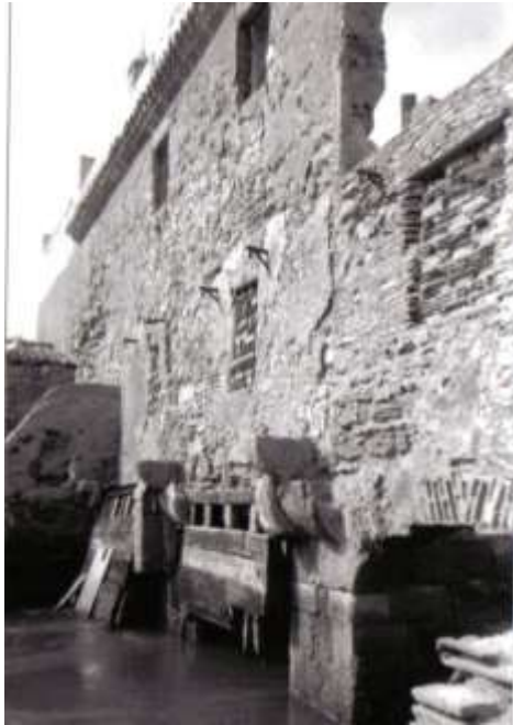
FIGURA 14 COMPUERTA. MOLINO DE RÍO ARILLO
