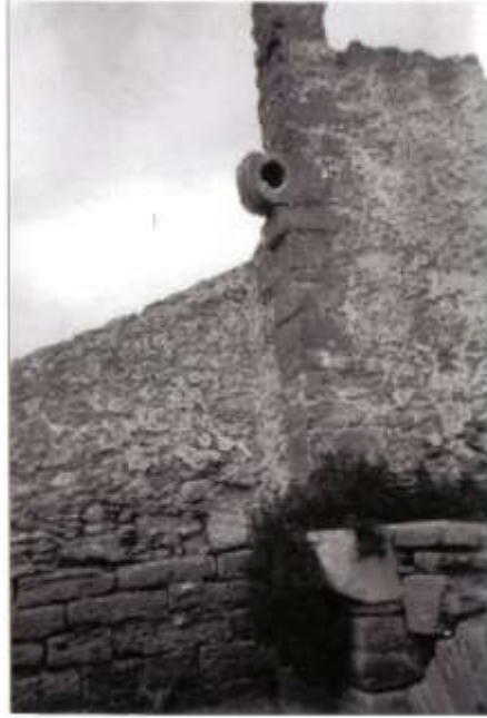
FIGURA 18 COMPUERTA EXENTA. MOLINO DE SAN JOSÉ. DETALLE.
