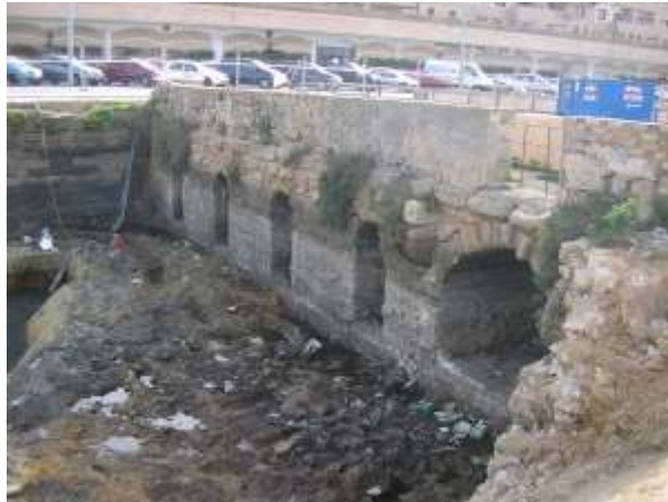
FIGURA 12. PRESA. MOLINO DE CAÑO HERRERA
