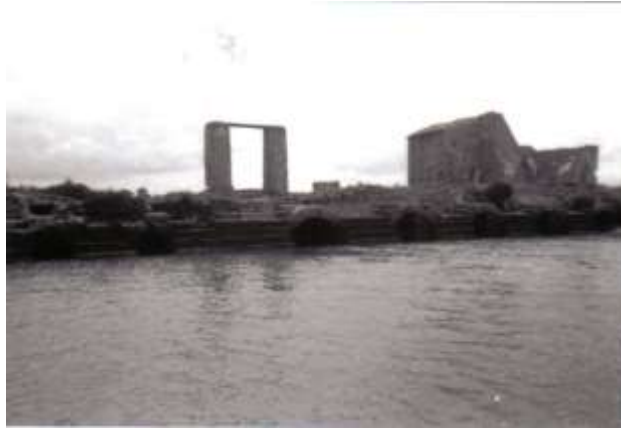
FIGURA 16 SOPORTE DE LA COMPUERTA VERTICAL. MOLINO DE SAN JOSÉ.
