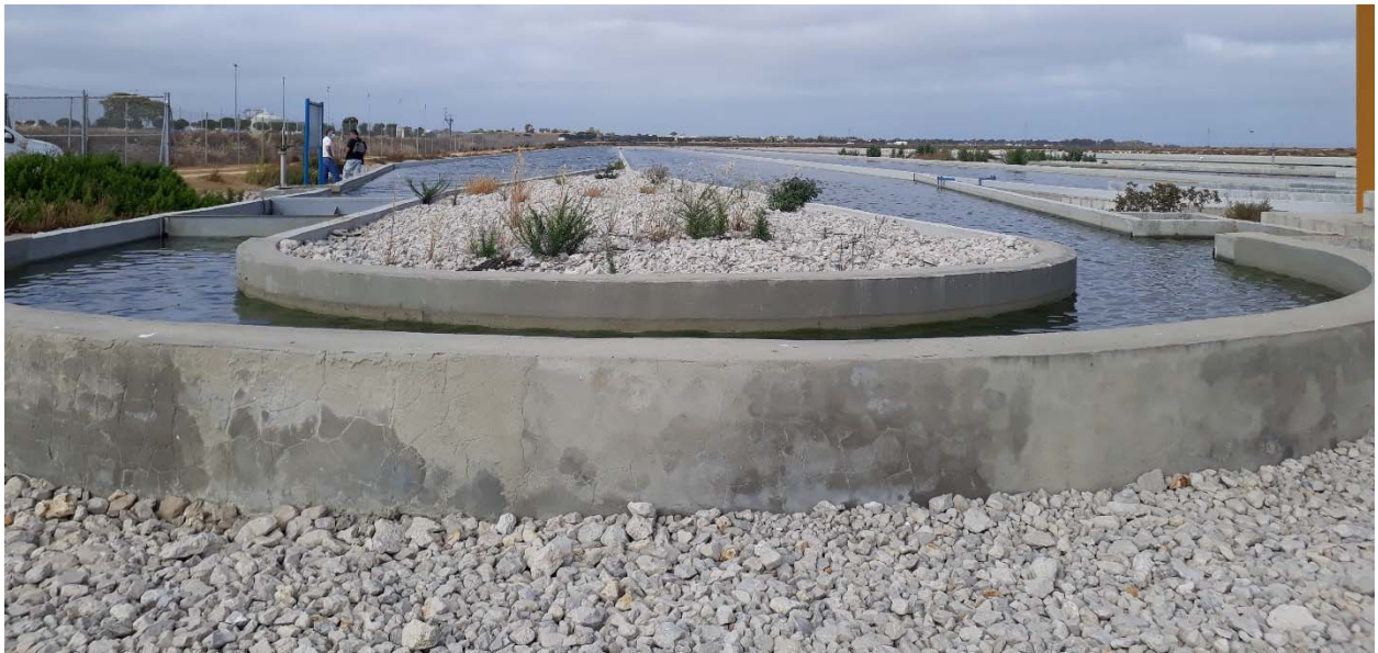
Figura 12: Recorrido por EDAR EL Torno. Vista de lagunas para microalgas: raceways convencionales.
