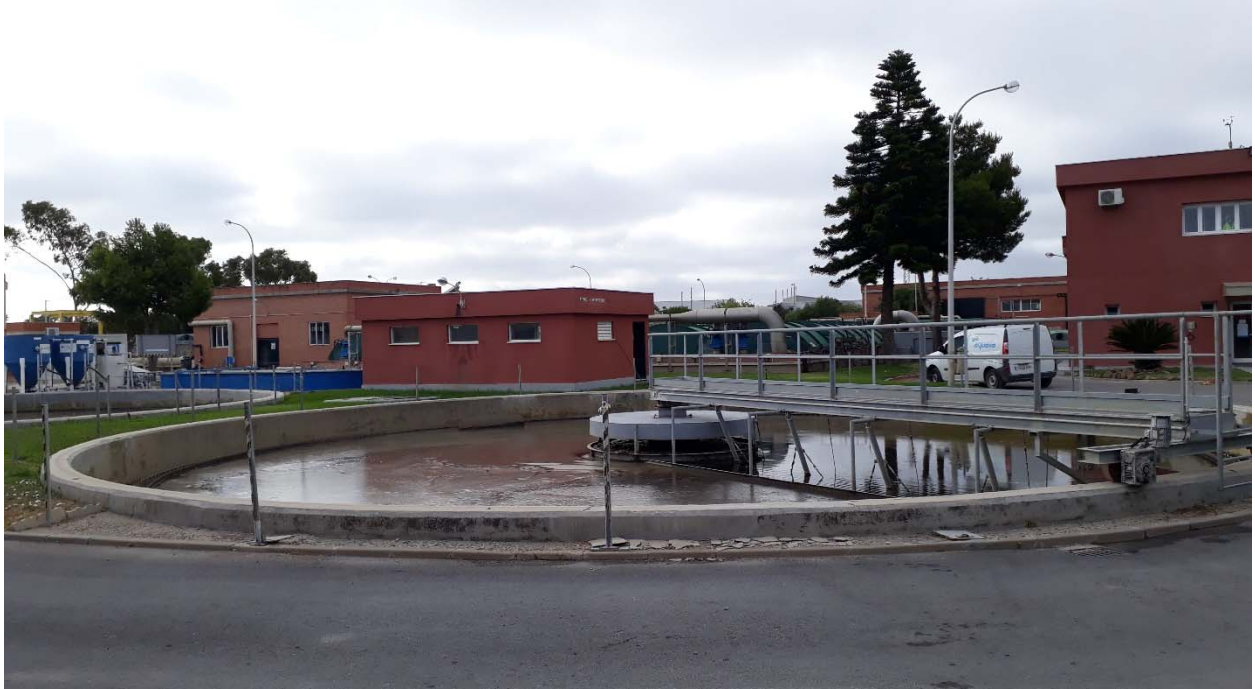
Figura 11: Recorrido por EDAR EL Torno. Vista de sedimentador secundario.
