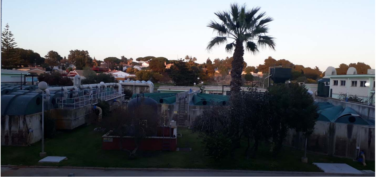
Figura 9: Recorrido por EDAR La Barrosa. Vista oeste de las instalaciones
