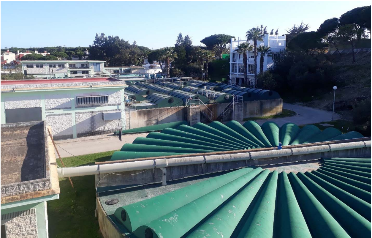
Figura 10: Recorrido por EDAR La Barrosa. Vista de Sedimentador secundario, reactor biológico de fangos activos, sedimentador primario, edificio de pre-tratamiento y edificio de control.
