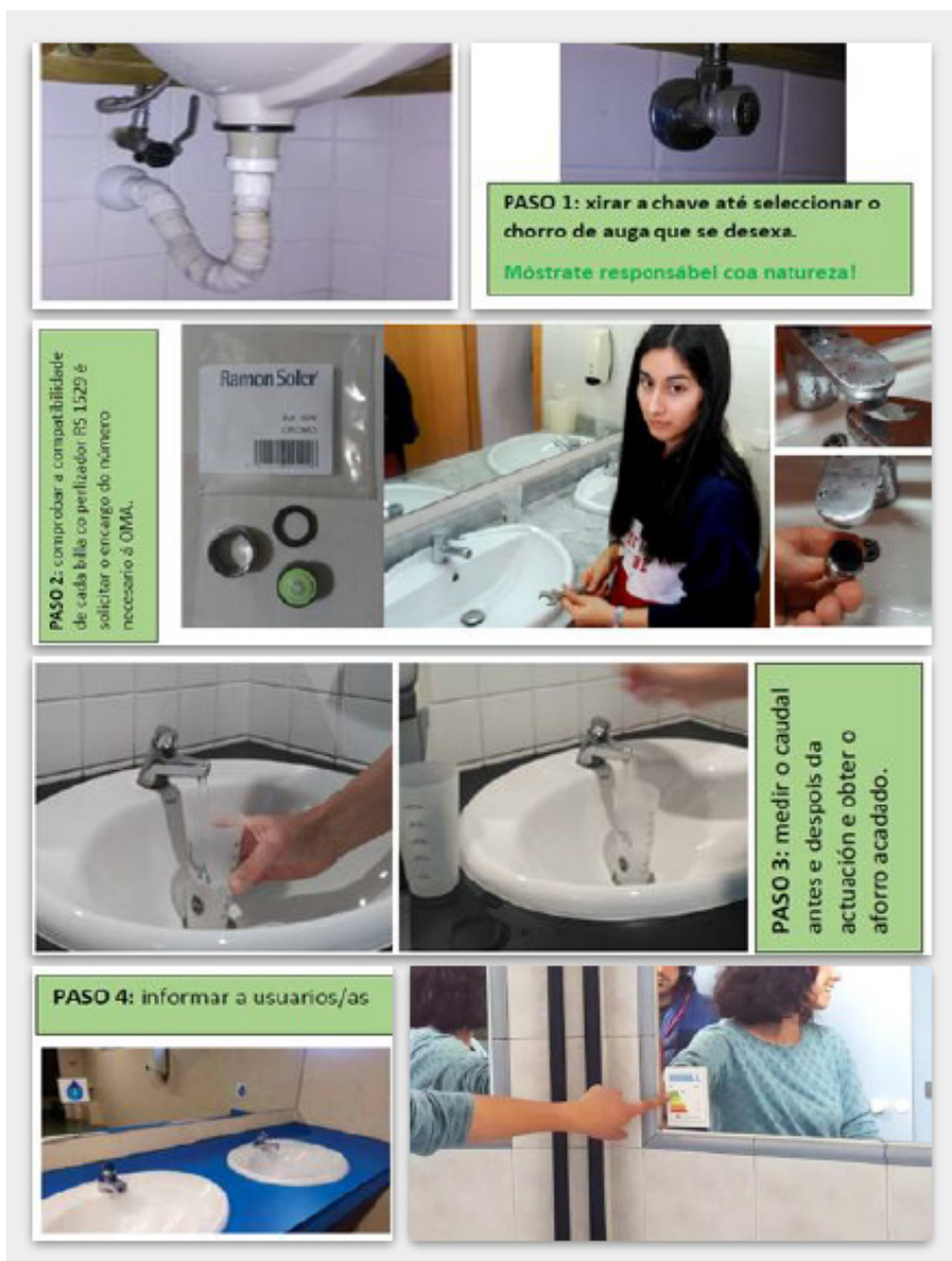
Figura 1. O aforo de auga en 4 pasos (OMA, 2017)
