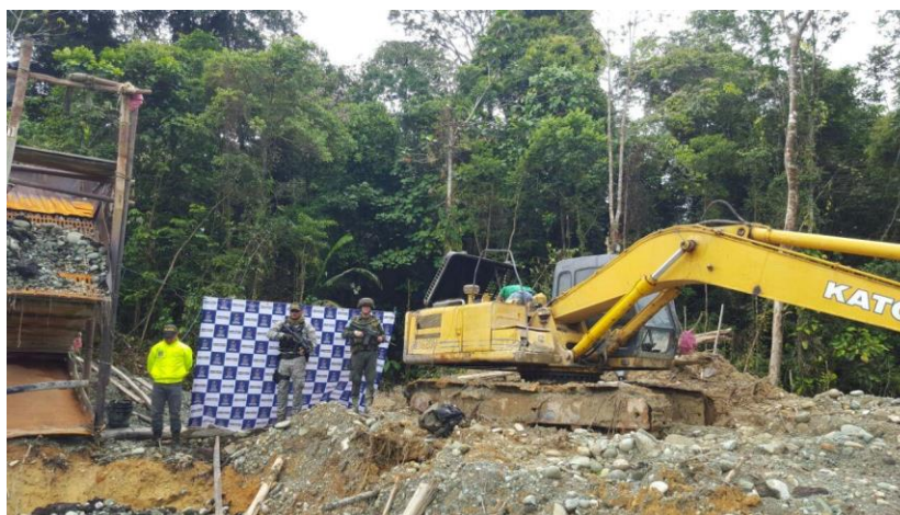
Figura 19. Destrucción de retroexcavadora
