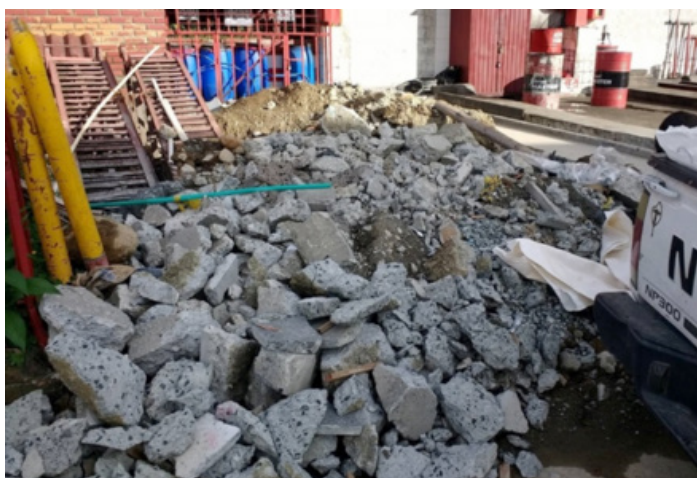
Figura 1. Demolición Avenida del Río, calle 4.
