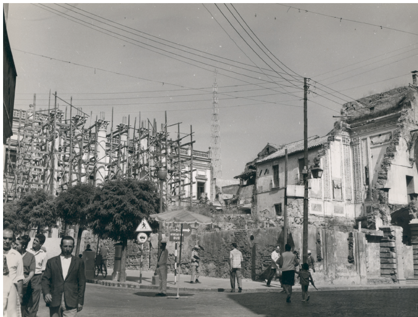
Fig. 7. Reconstrucción del pórtico del templo, diseñada por Félix Hernández, y vista parcial de la parte aún no demolida del ayuntamiento, 1969 (Archivo Municipal de Córdoba, FO010101-A00155-0005-0030)
