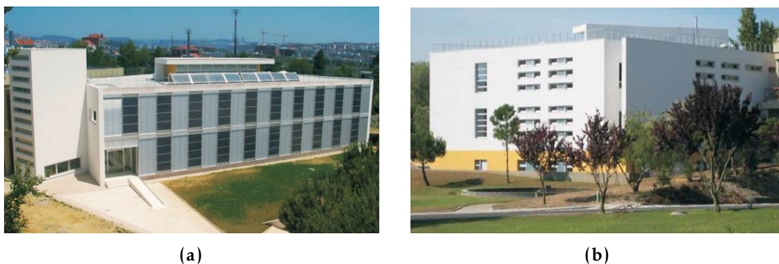
Figura 4.1: Edifício Solar XXI. (a) Fachadas Sul - Poente; (b) Fachadas Nascente – Norte. (Retirado de Andrade, 2009).
