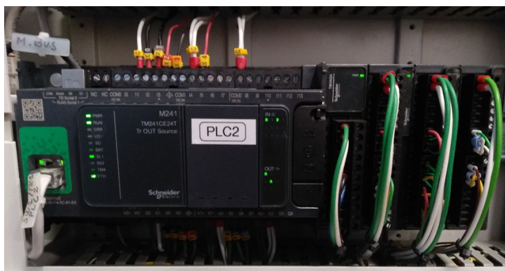
Figura 5.1: Controlador lógico programável, TM241CE24T, instalado na Test Room 2 . (Retirado de Schneider Electric, 2019b).
