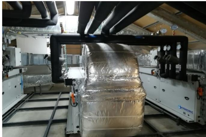
Figura 4.12 Zona de cobertura destinada a área técnica com unidade de tratamento de ar (UTA)
