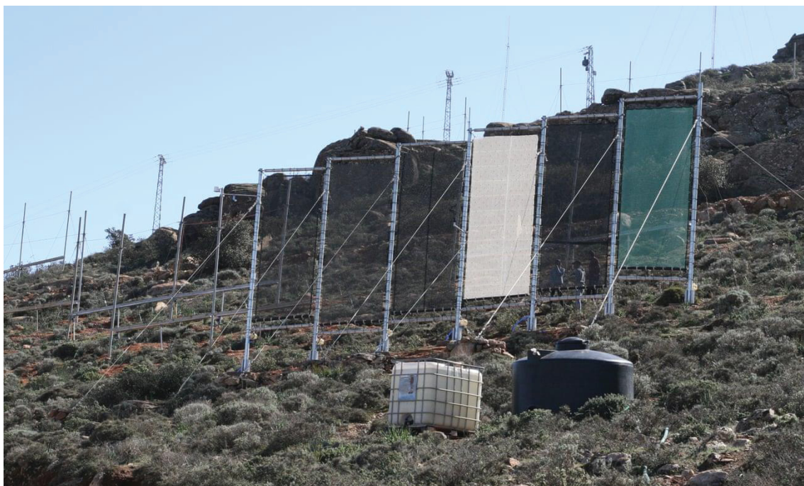
Figura 3.2 – O maior sistema de rede do mundo para captação de nevoeiro, instalado no monte Boutmezguida (Fotografia da ONG Dar Si Hmad).
