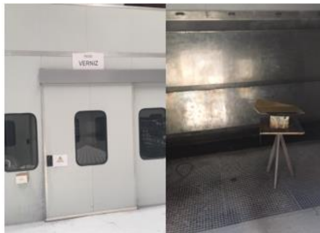
Figura 13 – Posto de aplicação de verniz
