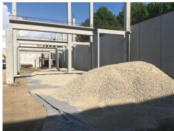
Figura 4.65 - Vista geral sobre a estrutura pré-fabricada
