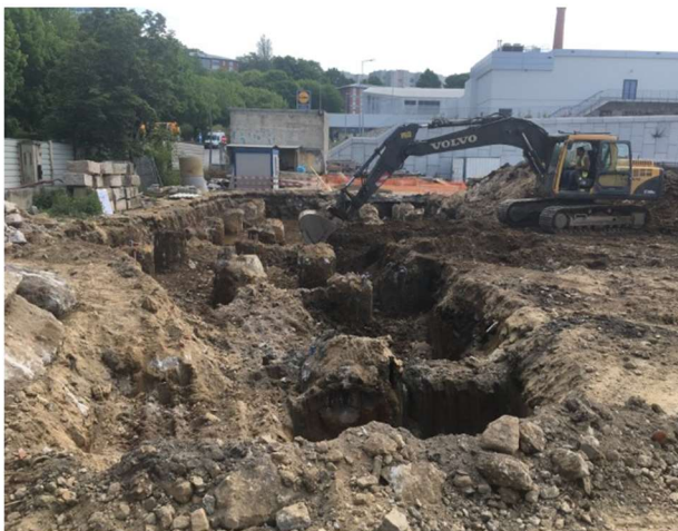
Figura 4.30 - Abertura de caboucos recorrendo a uma giratória
