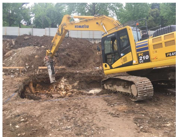
Figura 4.31 - Demolição de fundações pré-existent
