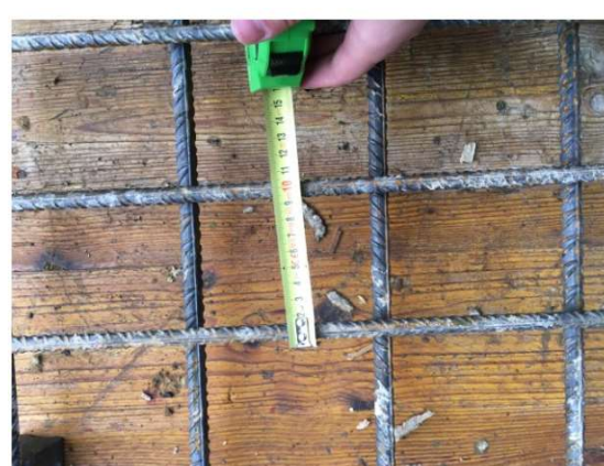
Figura 4.17 - Verificação da armadura superior longitudinal
