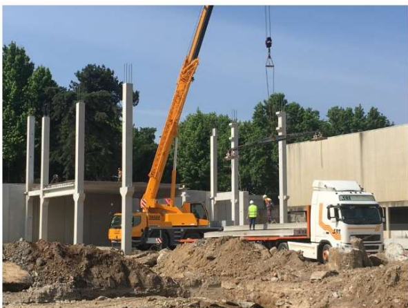
Figura 4.60 - Montagem das lajes pré fabricadas
