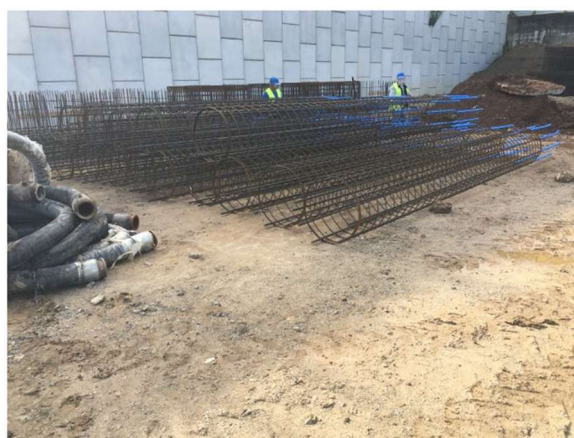
Figura 4.27 - Armaduras de estacas pré-fabricadas
