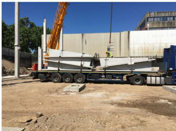
Figura 4.52 - Receção dos painéis do muro de contrafortes ao estaleiro de obra
