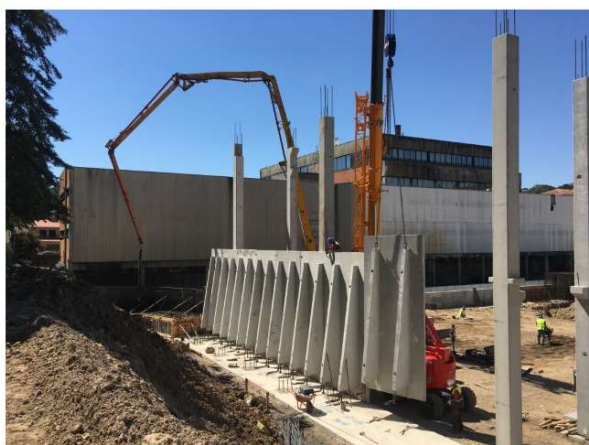
Figura 4.54 - Movimentação e colocação dos painéis do muro de contrafortes
