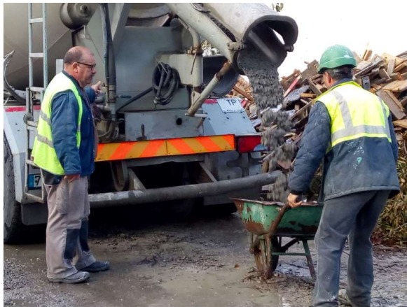
Figura 4.18 - Preparação para o ensaio Slump
