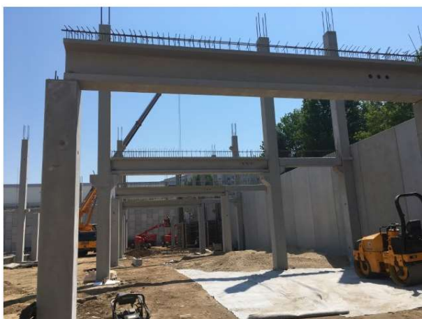
Figura 4.66 - Aspeto geral sobre a estrutura pré-fabricada
