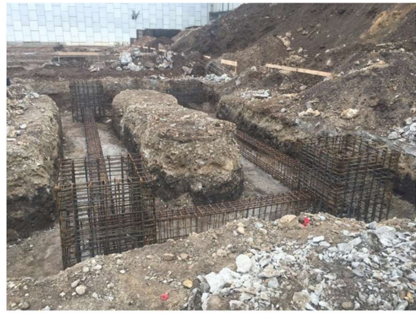
Figura 4.37 - Aspecto final da fundação
