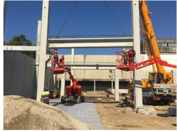
Figura 4.57 - Montagem das vigas pré-fabricadas
