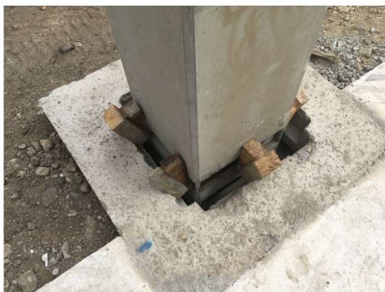
Figura 4.50 - Colocação de cunhas para garantir o alinhamento do pilar
