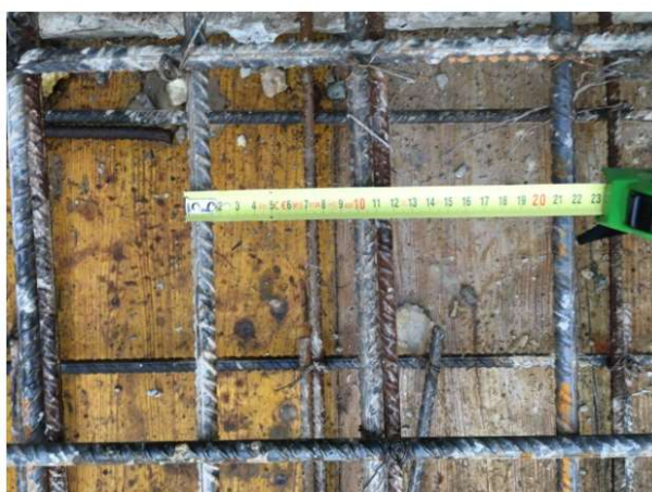
Figura 4.14 - Verificação da armadura superior transversal
