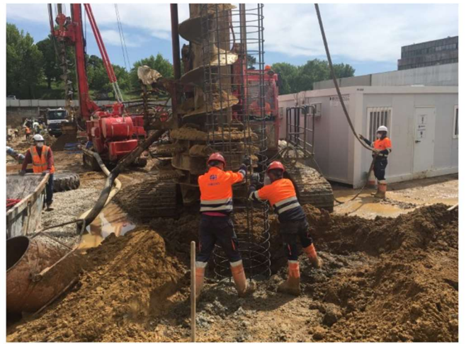
Figura 4.29 – Cravação da armadura da estaca no respetivo furo
