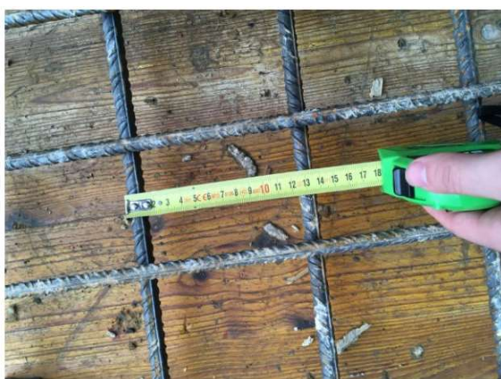
Figura 4.16 - Verificação da armadura superior transversal
