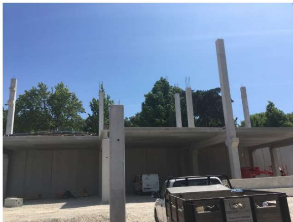
Figura 4.61 - Vista geral sobre a montagem das lajes pré-fabricadas
