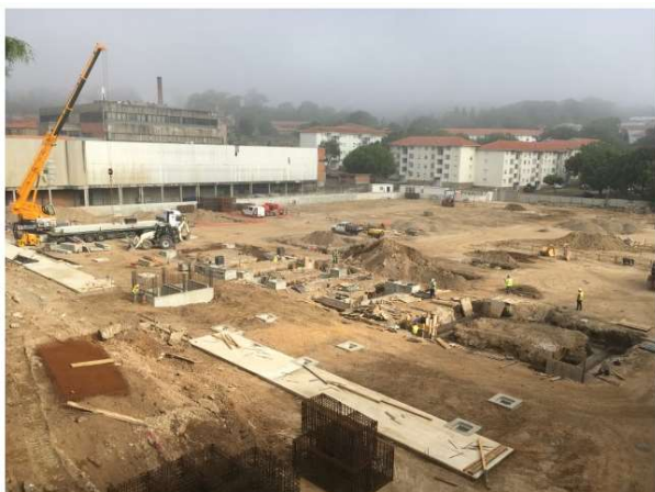
Figura 4.64 - Obra em fase inicial da montagem da estrutura pré-fabricada
