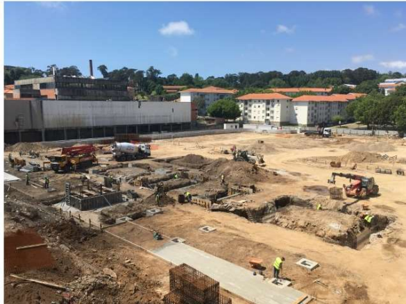
Figura 4.63 - Obra em fase de cofragens e betonagens de fundações
