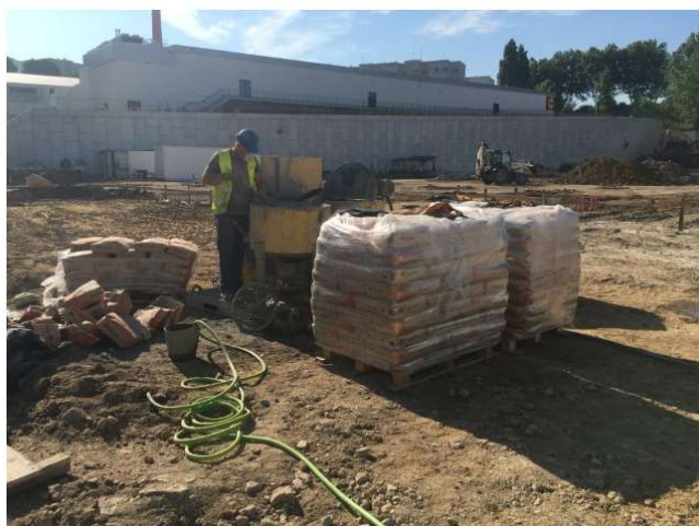
Figura 4.40 - Produção de calda de cimento
