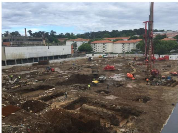
Figura 4.62 - Obra em fase de execução de fundações indiretas por estacas
