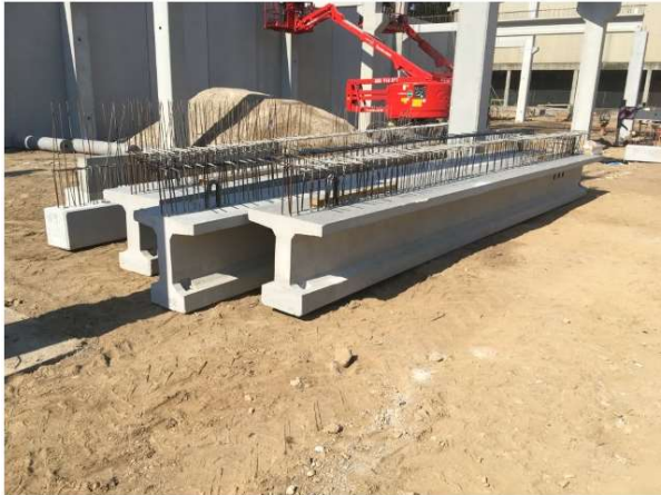
Figura 4.56 - Chegada das vigas pré-fabricadas ao estaleiro de obra
