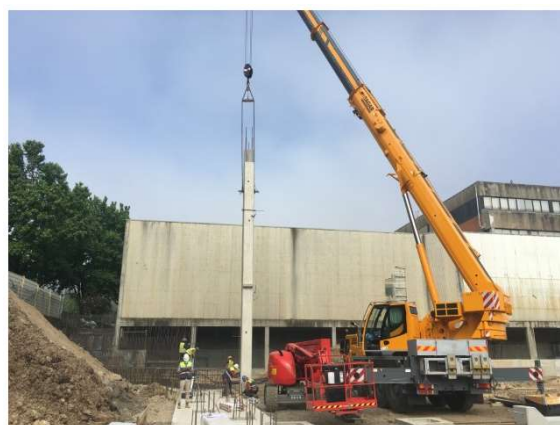
Figura 4.49 - Movimentação e colocação dos pilares, recorrendo a auto-grua
