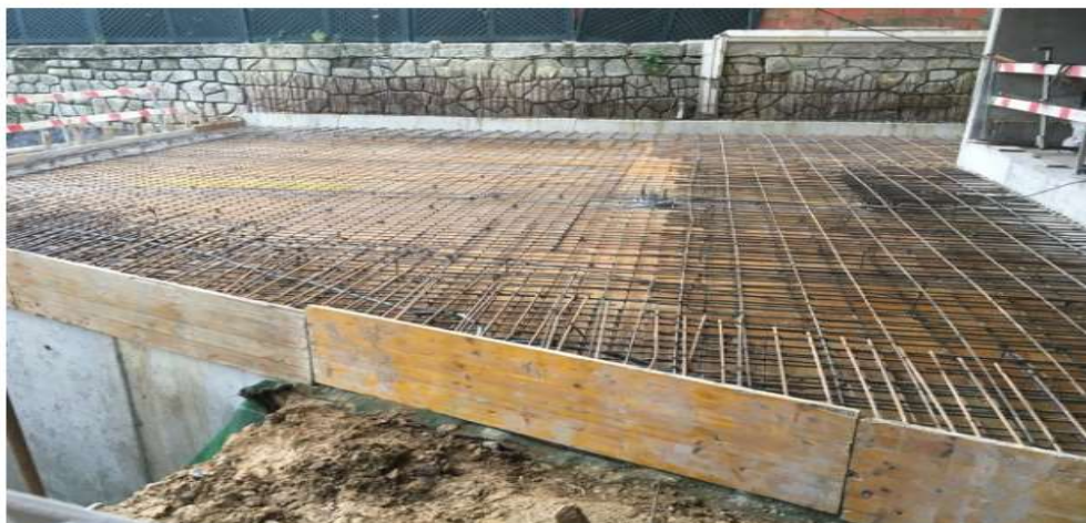
Figura 4.13 - Armadura de laje
