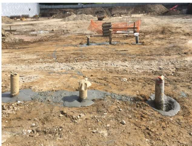
Figura 4.41 - Conclusão da execução das micro estacas
