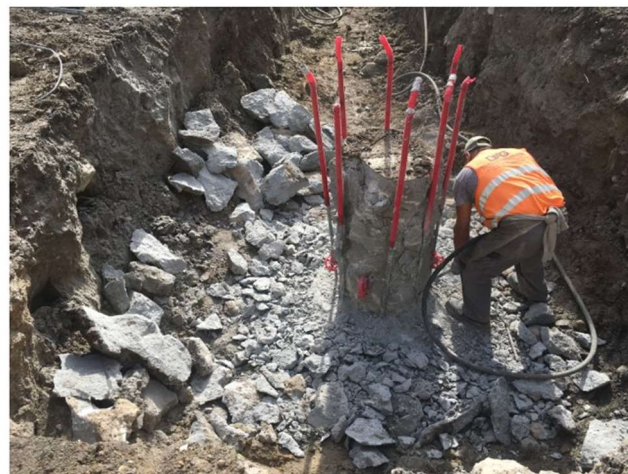
Figura 4.33 - Perfuração do betão com martelo pneumático
