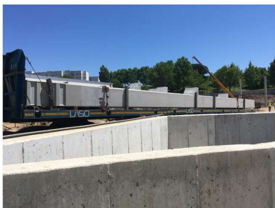
Figura 4.48 - Receção dos pilares pré-fabricados ao estaleiro de obra
