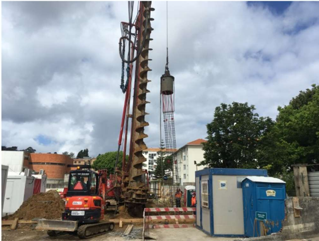
Figura 4.28 – Colocação da armadura no prato da perfuratriz
