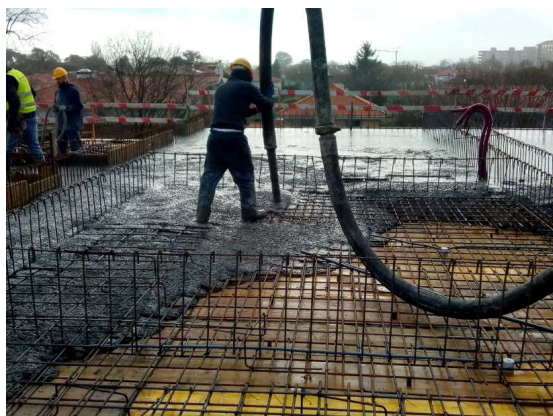
Figura 4.22 - Execução da betonagem
