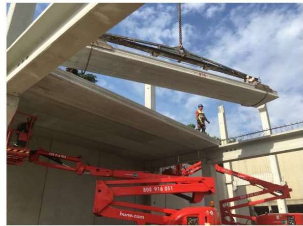
Figura 4.59 - Transporte e montagem das lajes alveolares pré-fabricadas
