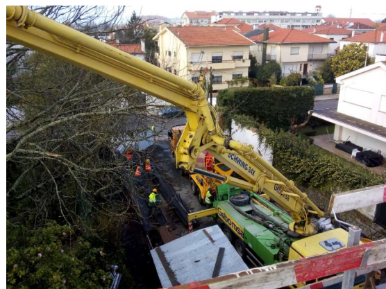
Figura 4.21 - Betonagem com recurso a bomba
