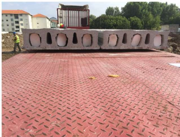
Figura 4.58 - Chegada das lajes alveolares ao estaleiro de obra
