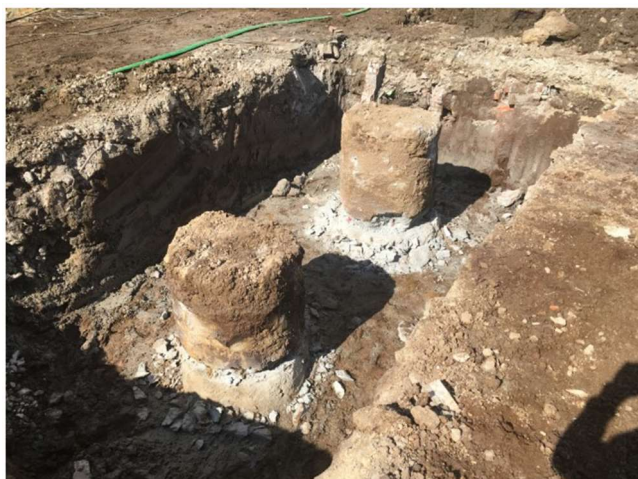
Figura 4.32 - Cabeças de estaca prontas para a fase de saneamento
