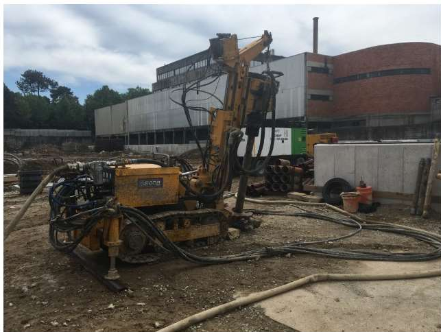
Figura 4.38 - Máquina utilizada para a execução de micro estacas
