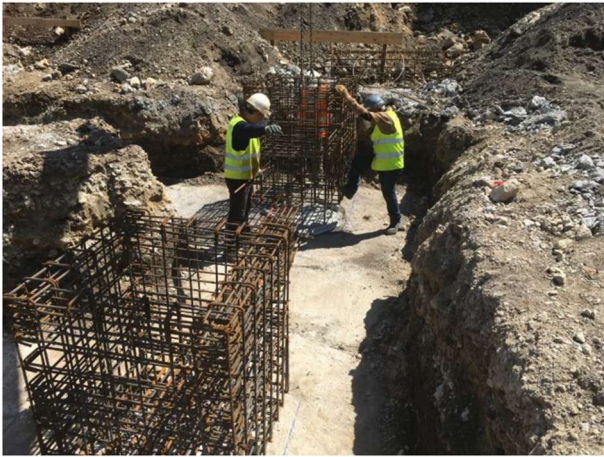
Figura 4.36 - Transporte e colocação de armaduras de maciços e vigas de fundação
