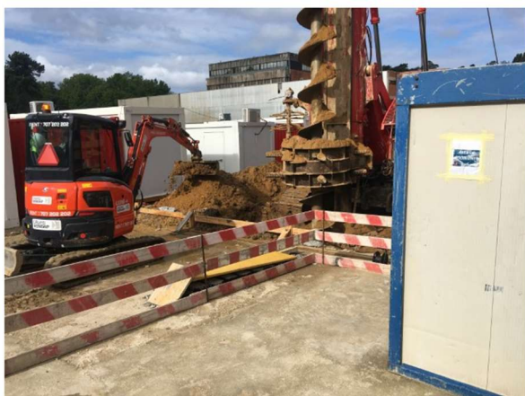
Figura 4.24 - Execução do furo com perfuratriz vertical
