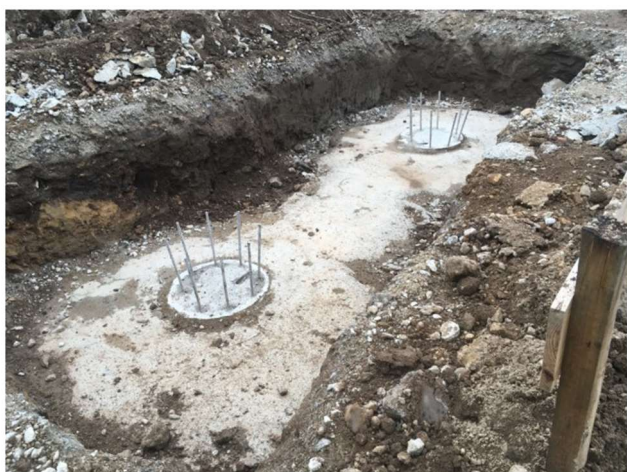
Figura 4.34 - Finalização da fase de saneamento
