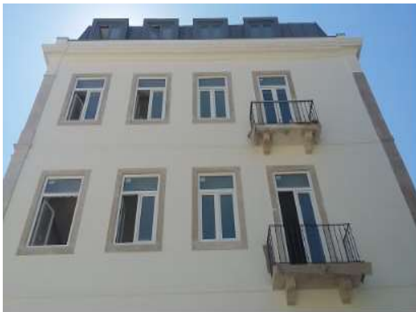
Figura 2.8 – Reabilitação de um edifício na Rua Miguel Lupi, Lisboa – (Fonte: [1])
