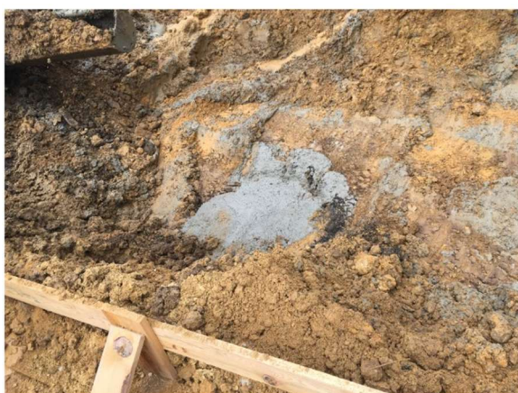
Figura 4.26 - Aspeto final da furação
