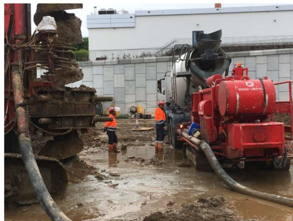
Figura 4.25 - Bombagem de betão para o tubo central do trado
