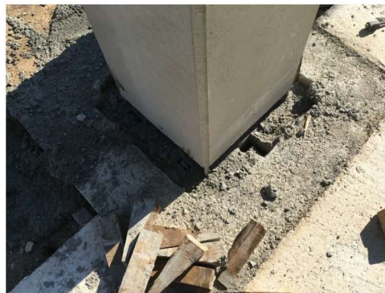
Figura 4.51 - Selagem dos negativos dos pilares, com betão
