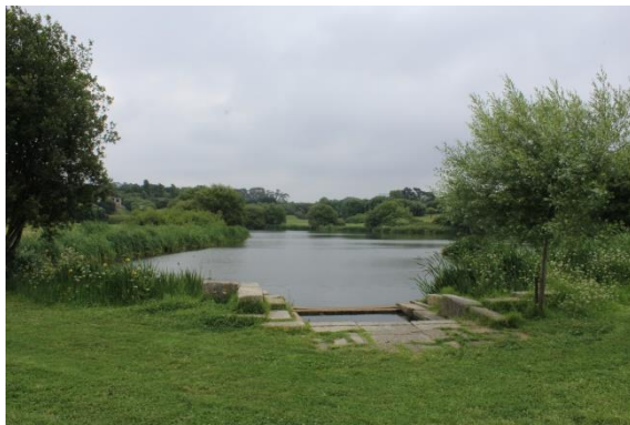
Figura 3.7 Vista geral do Lago 3.
