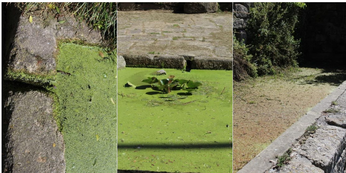
Figura 4.17 Condições do Tanque 2, 3 e 4 (da esquerda para a direita).
