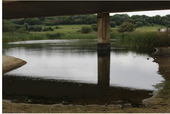
Figura 3.8 Vista geral do Lago 4.
