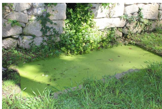
Figura 3.12 Vista geral do Tanque 1.
