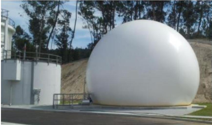
**Figura 7: Imagem cedida pela companhia SOTECNOSOL, referente a um gasômetro conectado a um biodigestor de batelada (BATE) no ano de 2020 [127].**
