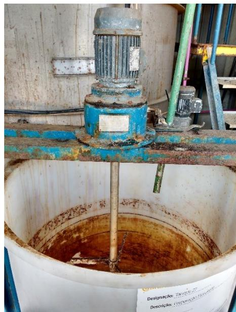
Figura 2.11 - Agitador do Floculante
