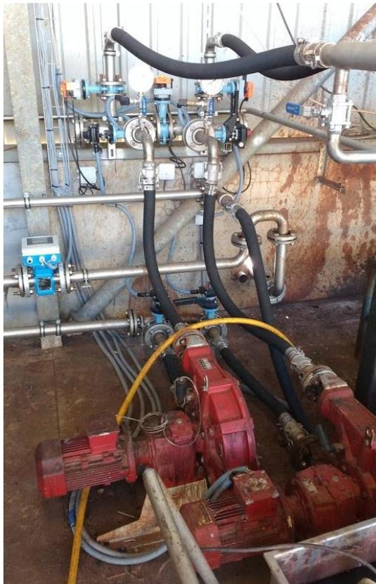
Figura 4.10 - Bombas Peristálticas + Coletor
