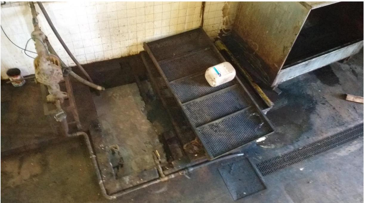
Figura 2.4 - Tanque de Retenção (Zona de Recolha de Efluentes - ZELL)
