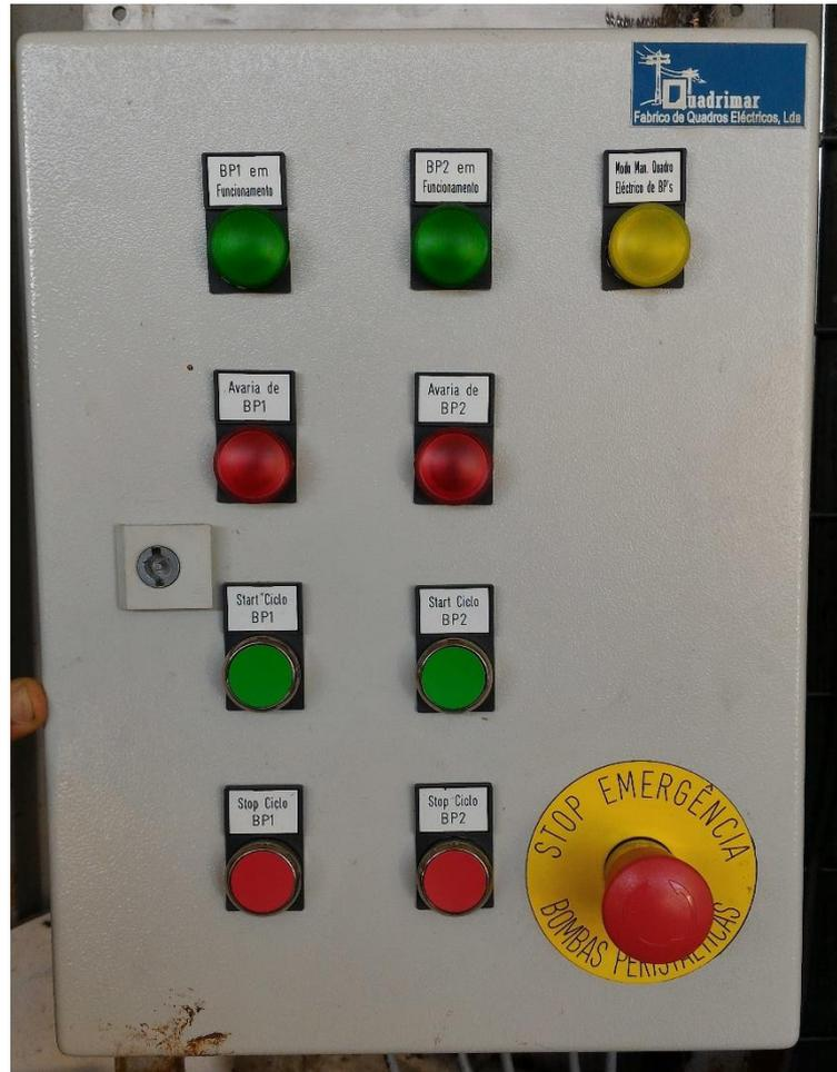
Figura 3.27 - P3 – Quadro de comando das Bombas Peristálticas
