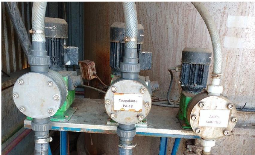
Figura 2.12 - Bomba Doseadora de coagulante e soda cáustica
