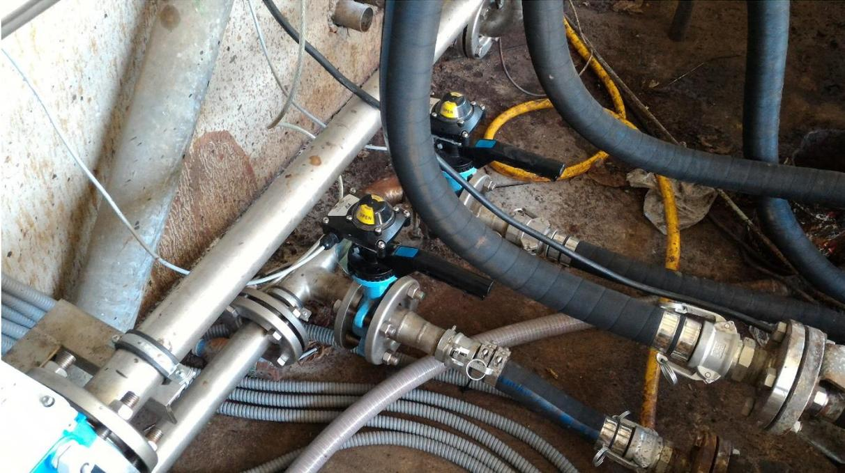
Figura 4.5 - Válvulas de Borboleta TTV + Fins de Curso Mecânicos TTV
