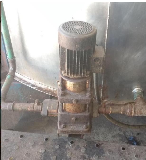
Figura 2.15 - Bomba do Tanque de Auto-Controlo
