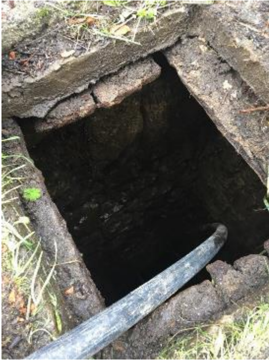
Figura 68 – Laje de proteção quadrada (fonte: própria).
