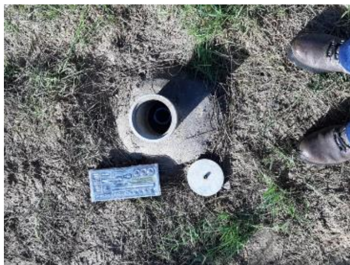
Figura 66 – Resultado final da instalação de um tubo piezométrico, onde o mesmo se encontra nivelado com a topografia do terreno e isolado do exterior, evitando qualquer tipo de contaminação ou acidentes (fonte: própria).
