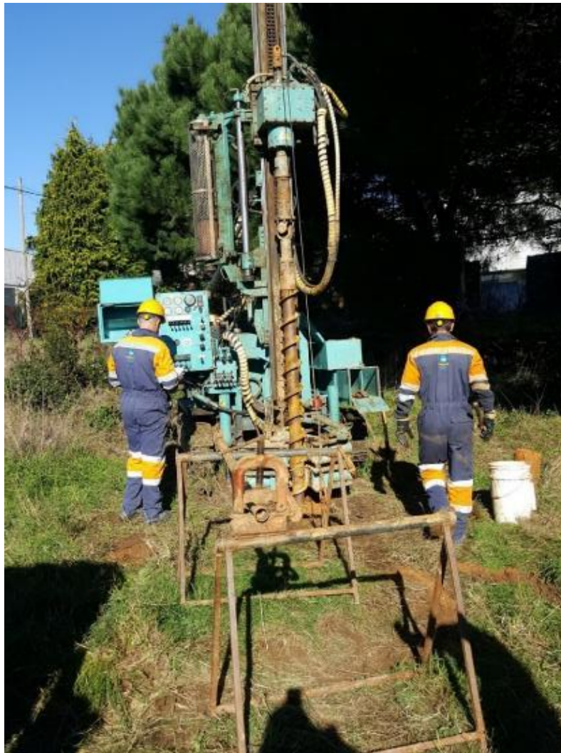
Figura 61 – Atlas Copco Mustang A32, utilizada nos trabalhos de prospecção (fonte: própria).
