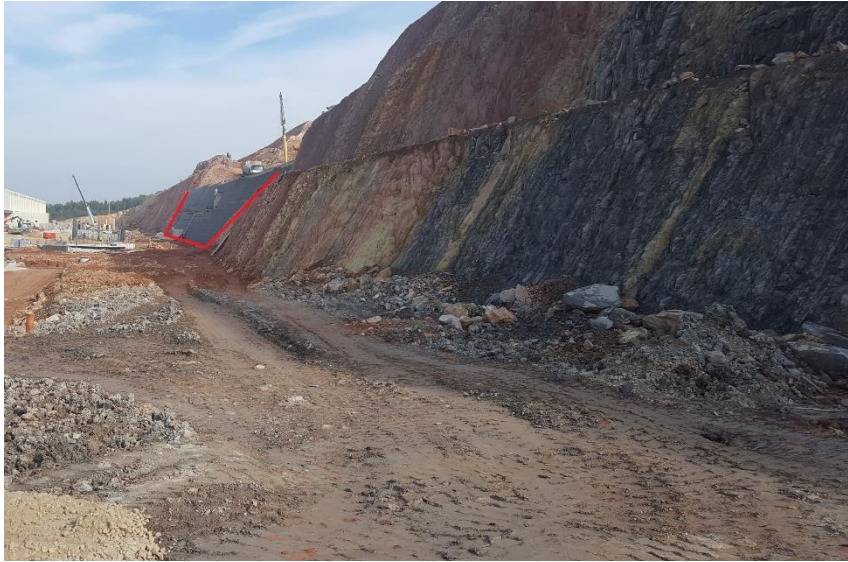
Figura 37 - Talude observado durante a visita ao terreno interessado para a realização de um furo de pesquisa e captação de água.
