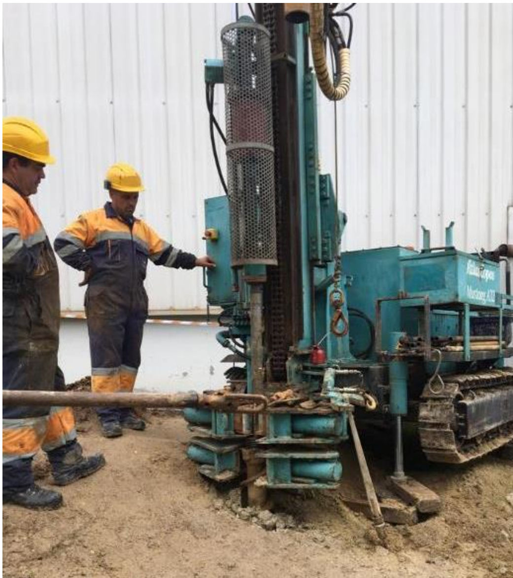
Figura 19 – Execução de ensaio SPT (fonte: própria).
