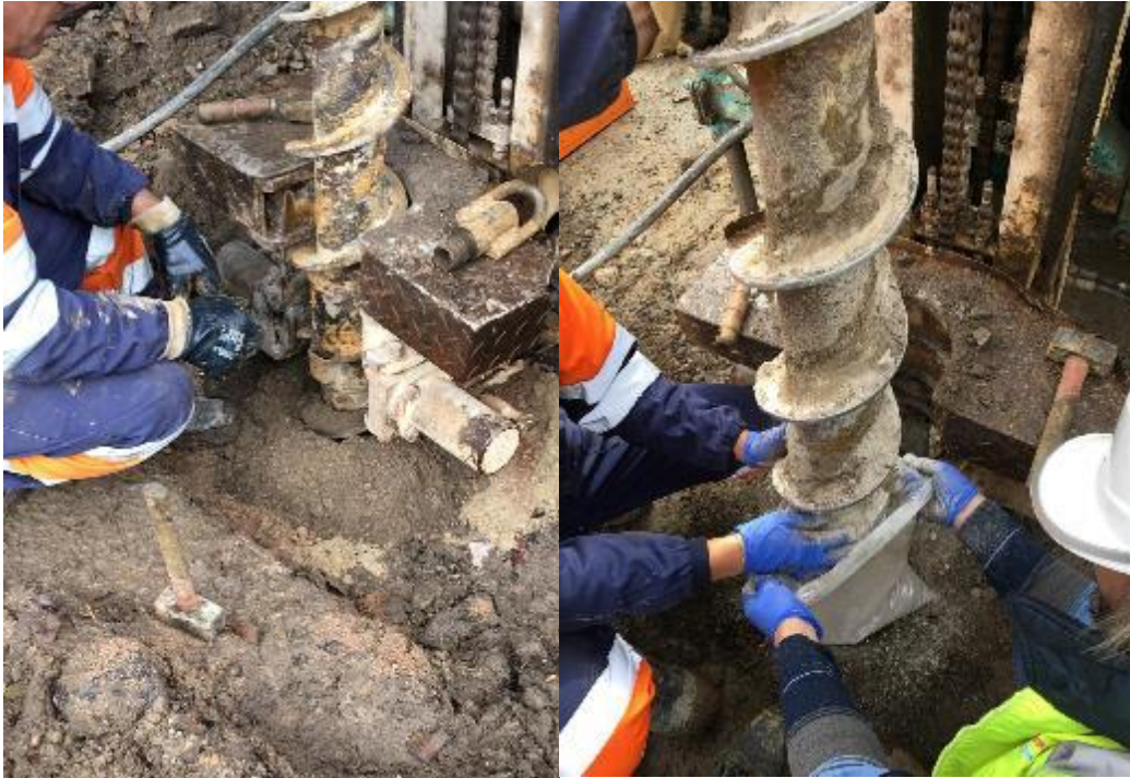
Figura 18 – Sondagem de furação à rotação com recurso a trado oco helicoidal (fonte: própria).
