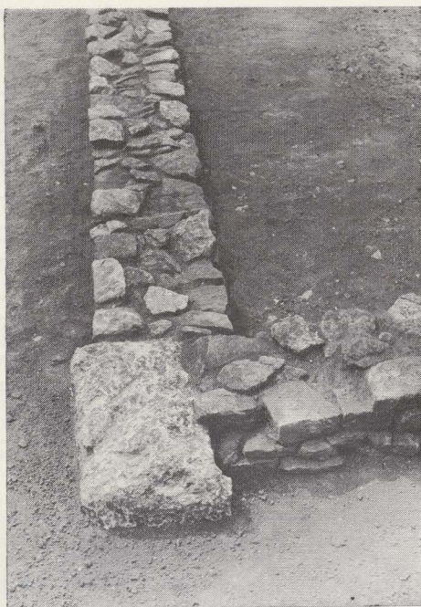
Fig. 16. — Bâtiment C : angle des murs nord et est renforcé par une pierre de taille.
