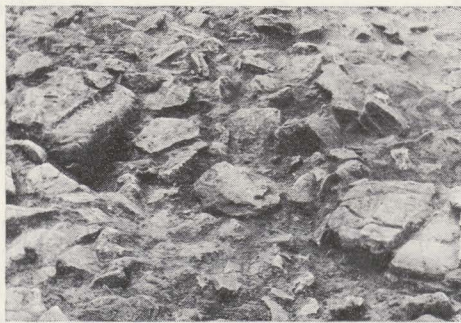
Fig. 23. — Bâtiment D : pierres de taille délimitant l'ouverture percée au centre du mur de refend.
