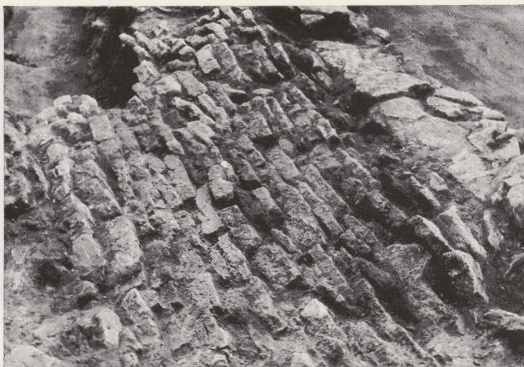
Fig. 24. Annexe D 1 : assises écroulées du mur nord, alignées sur le sol.
