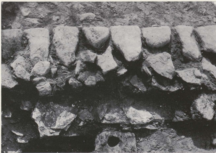
Fig. 27. — Construction H : détail du mur au parement de pierres taillées.
