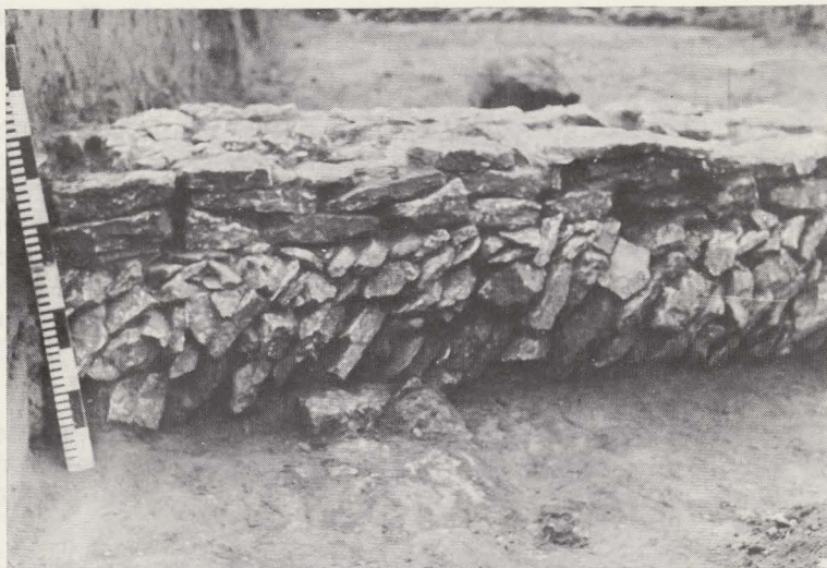
Fig. 9. — Pièce principale du bâtiment B : fondations de moellons dressés et parement du mur oriental.
