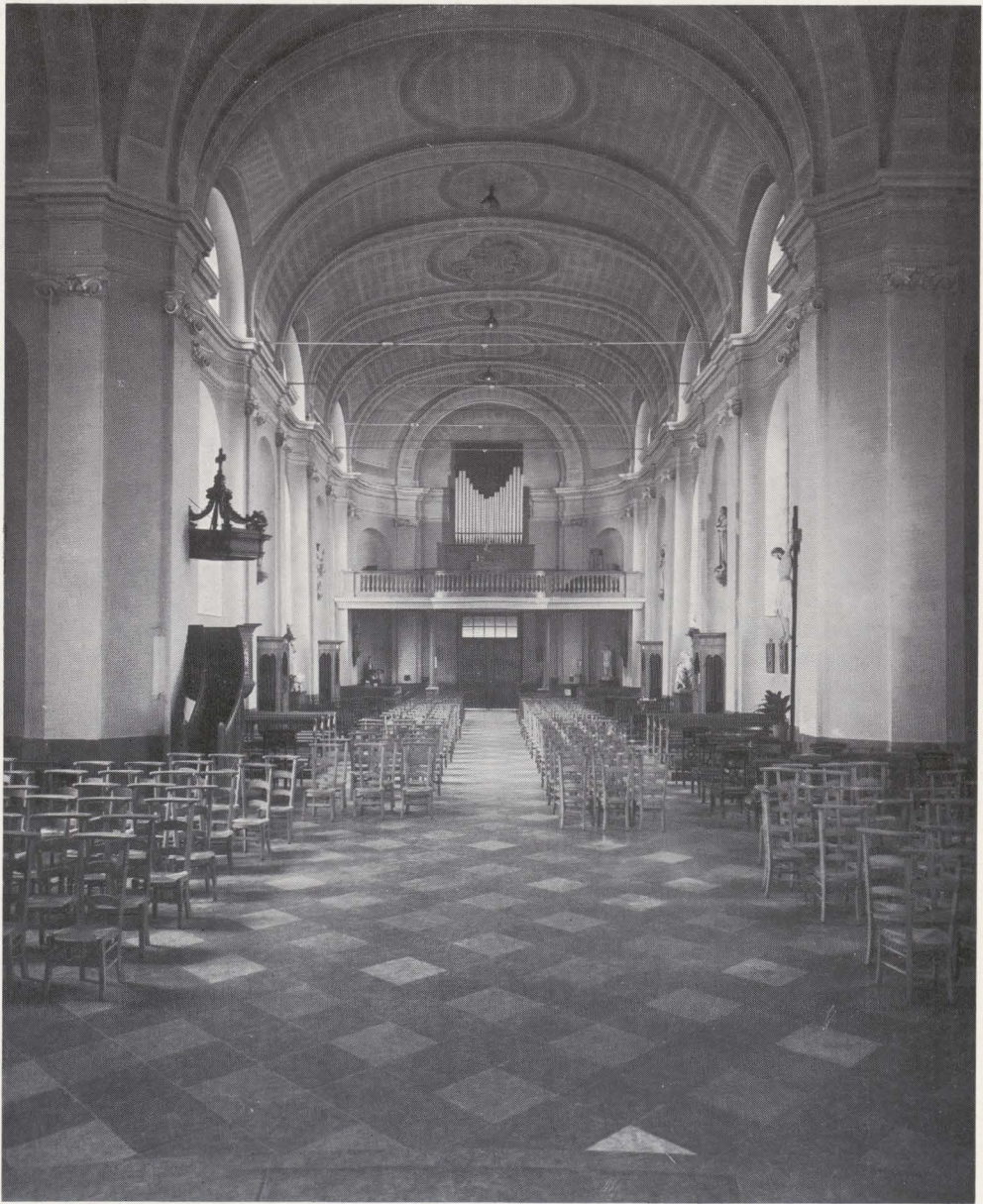
FIG. 10. — Vue intérieure de la nef, vers le jubé.
