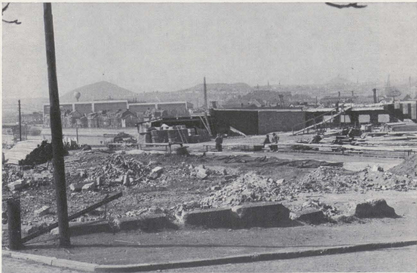
FIG. 26. — Construction du pont sur l'emplacement de l'église, détruite.
