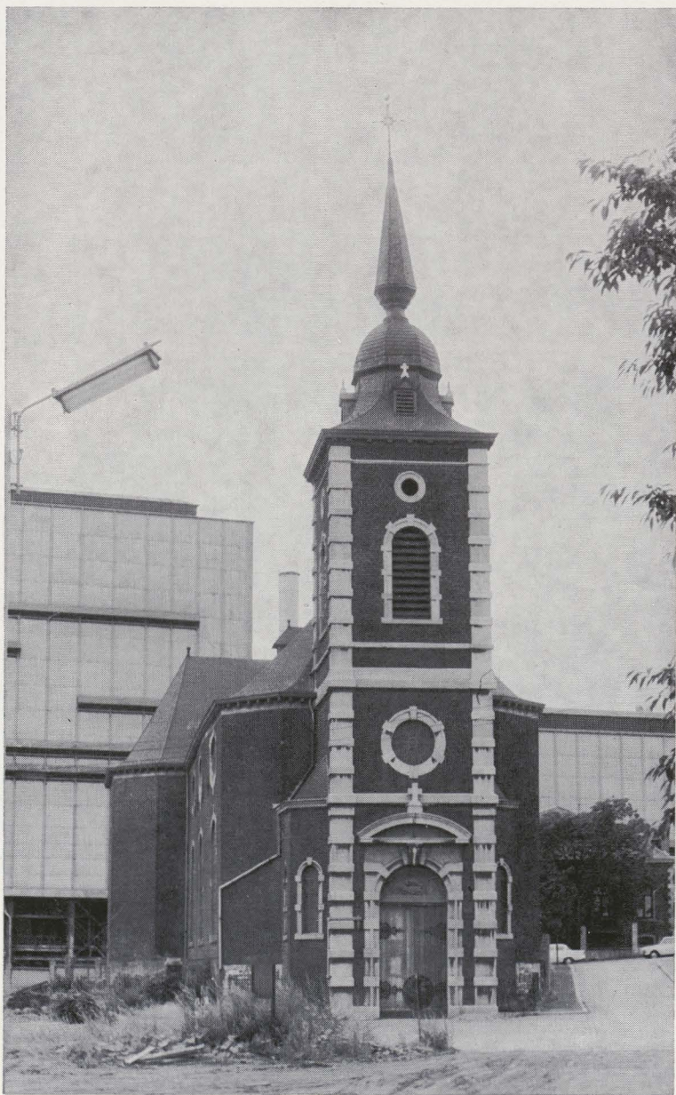
FIG. 9. — Vue de la tour, en 1965.
