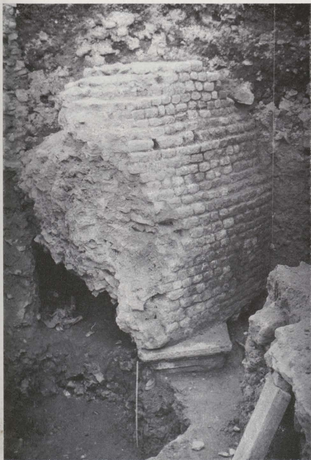
a) Tour de l'enceinte en cours de dégagement.
